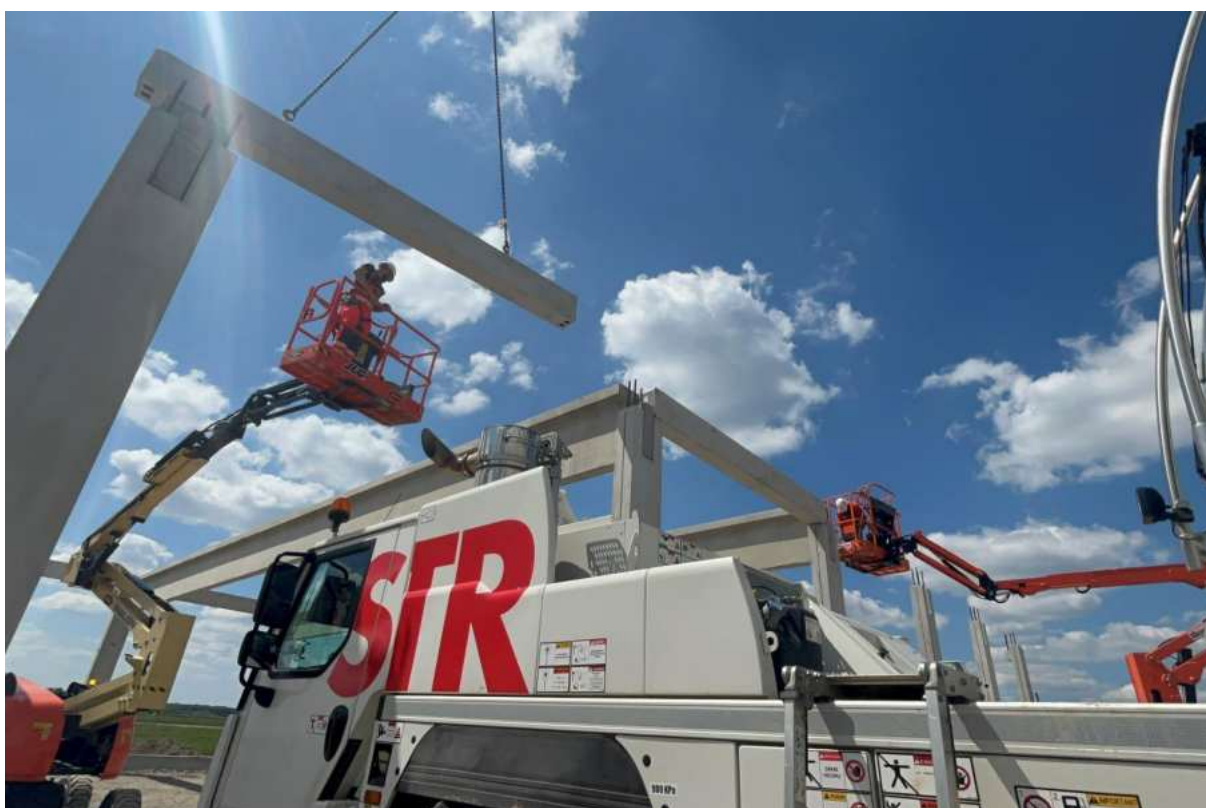
Montáž železobetónového skeletu predajne LIDL, Kúty
