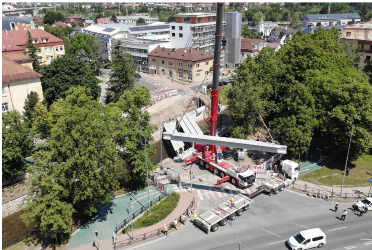
Montáž mosta, Poprad
