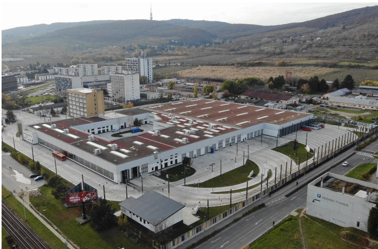
Modernizácia údržbovej základne, III. Etapa, Vozovňa Krasňany, Bratislava
