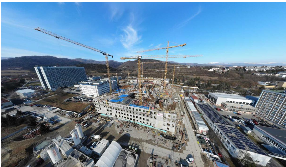
Výstavba FN sP F. D. Roosevelta, Banská Bystrica
