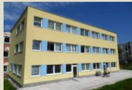
budova centra po rekonštrukcii
