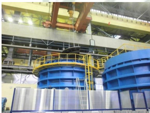
Obr. č. 14 a 15 / Inštalácia komponentov zvracieho polohovadla 100t
