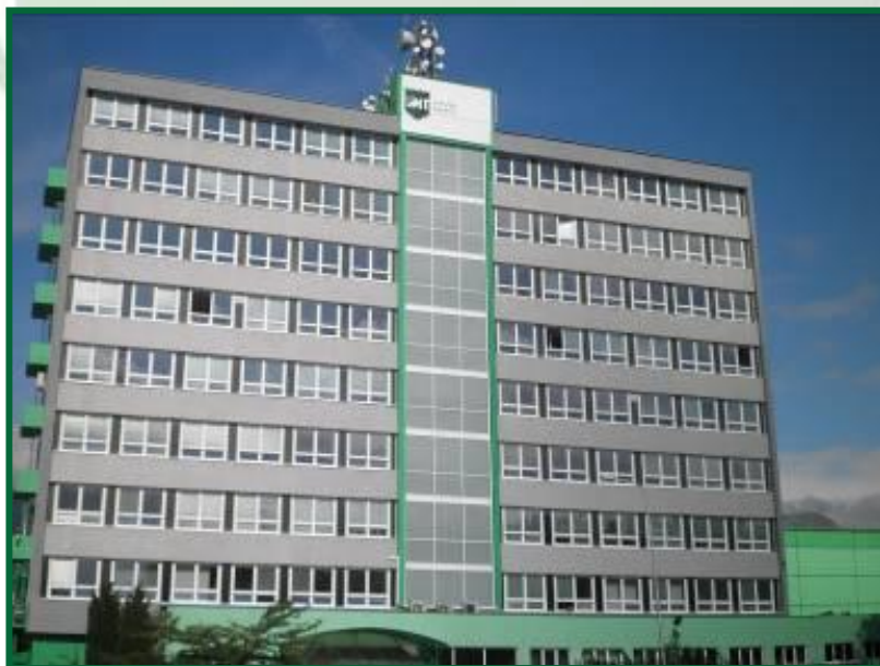
Obr. č. 1 / Pohľad na administratívnu budovu
