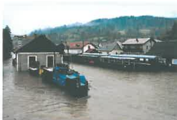
Zaplavená stanica Čiernohronskej železnice v Hronci vodami Čierneho Hrona
