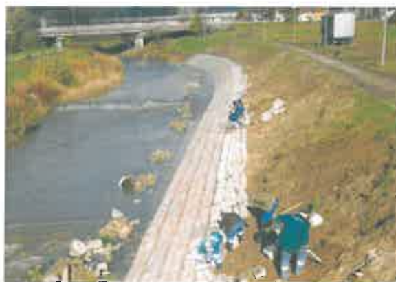
Oprava opevnenia koryta Torysy v Prešove
