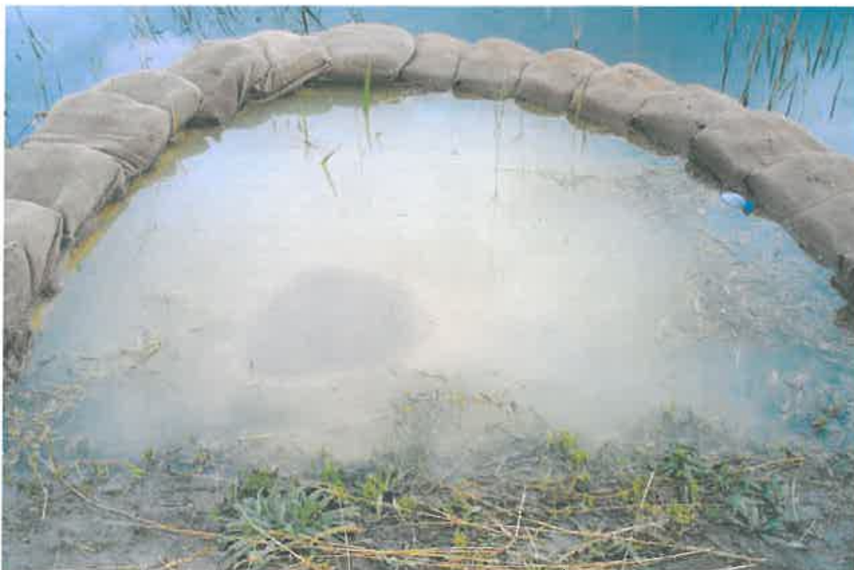
Tam, kde popod ochrannú hrádzu vytryskol výver sa vrecovalo kruhovým spôsobom, aby sa zabránilo jeho rozšíreniu
