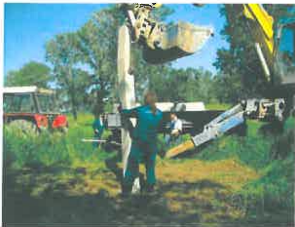
Osadzovanie stĺpa pre plavebný znak na vodnej ceste Bodrog
