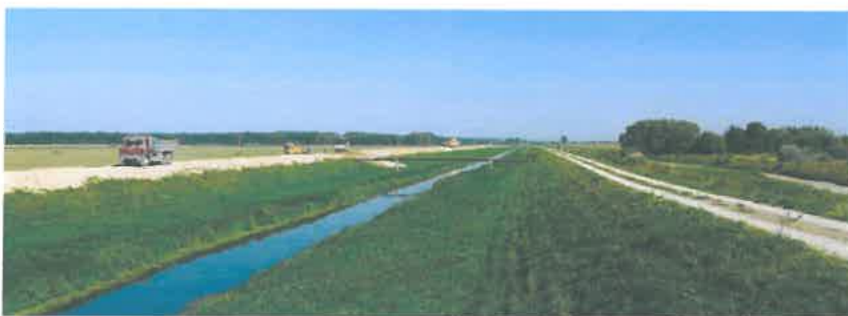
Rekonštrukcia ochranných hrádzi rieky Maliny
