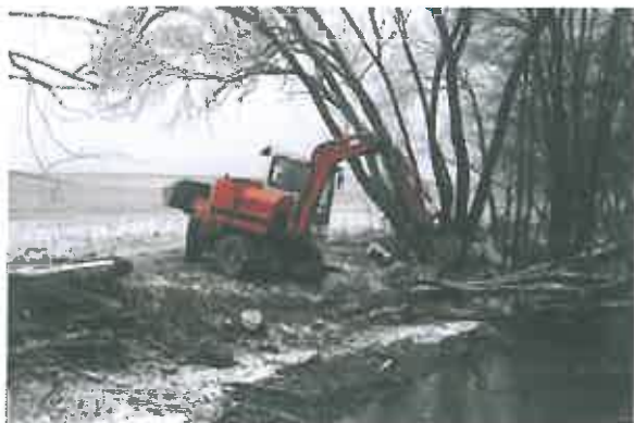
Odstraňovanie krovitého porastu a stromov na potoku Širočina v obci Tajná je súčasťou periodickej údržby vodných tokov
