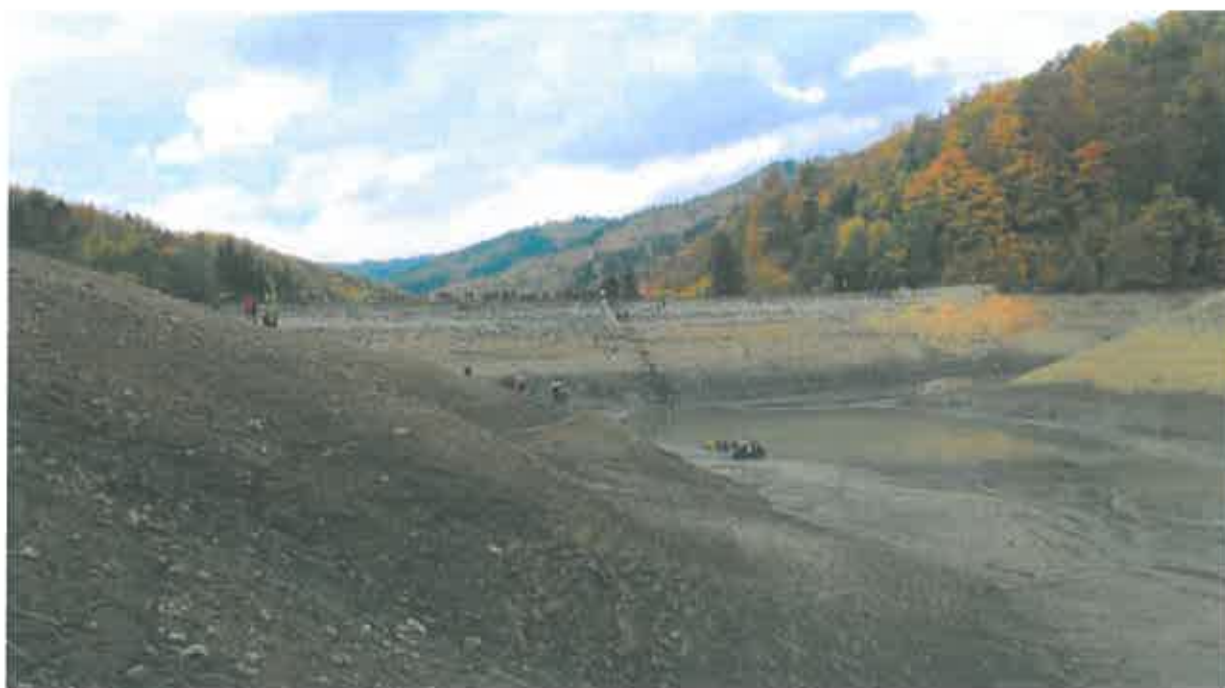
Vypustený Dolnohodušký tajch pred začiatkom rekonštrukcie
