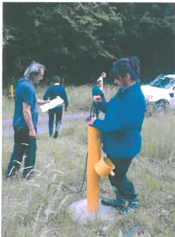
Kontrola pozorovacej sondy v rámci technicko-bezpečnostného dohľadu
