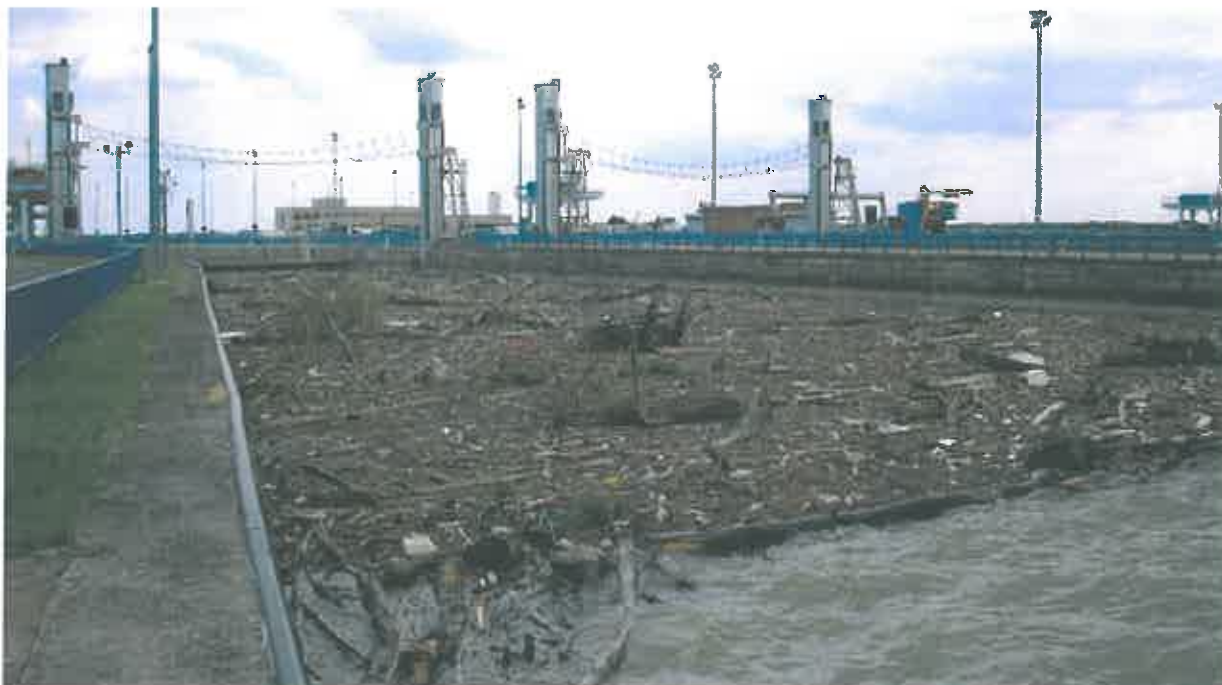
Pripravený odpad na plavebnej komore v Gabčíkove po povodni v júli 2013
