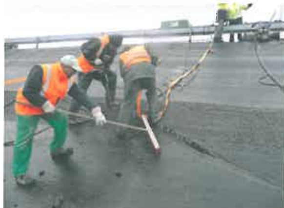
Oprava poškodeného asfaltobetónového plášťa ľavej strany prívodného kanála do Gabčíkova v októbri 2013
