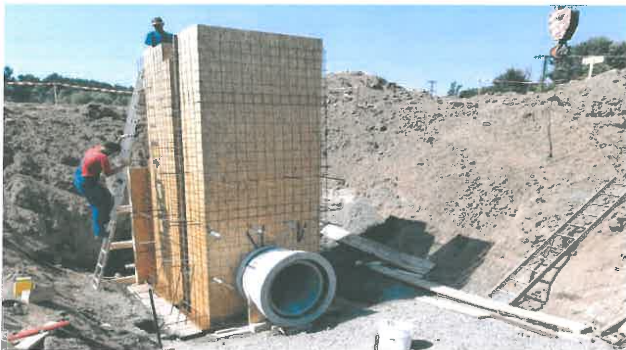
Sfunkčovanie hrádzového priepustu vo Vyškoviach nad Ipľom
