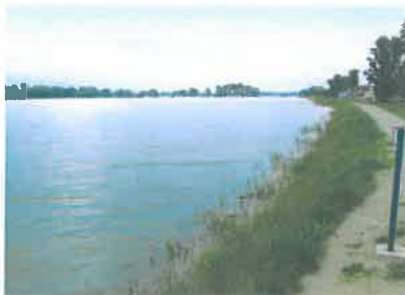
Dunajom vzdutá rieka Morava zaliala celé inundačné územie od Devínskej Novej Vsi - jej ďalšiemu rozlívaniu však už zabránila nová hrádza
