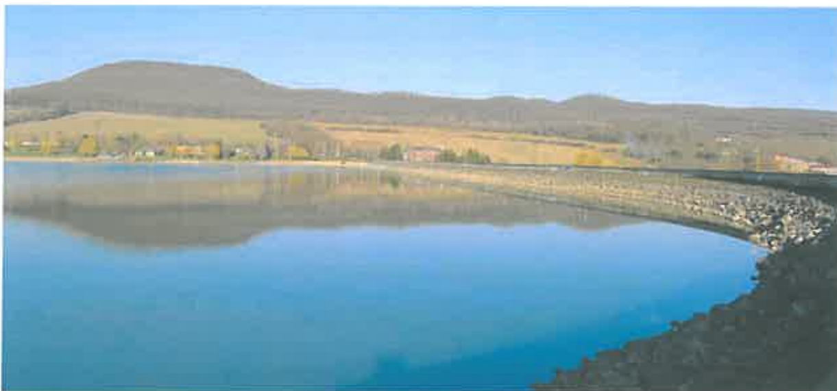
Vodná nádrž Teplý vrch čaká na rekonštrukciu bezpečnostného prípadu
