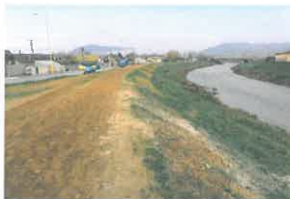
Prvá časť protipovodňových opatrení v Košičiach - hrádza v mestskej časti Džungľa
