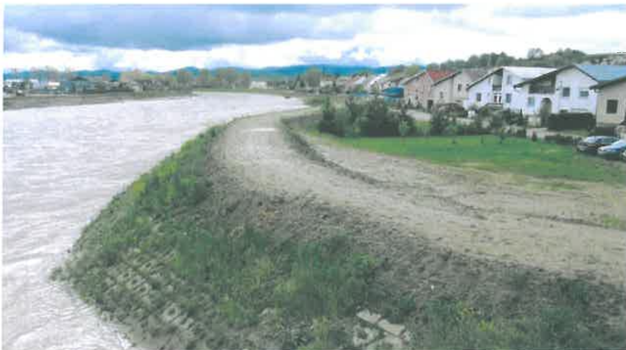
Nová ochranná hrádza v Starej Ľubovni
