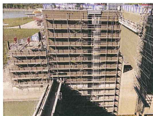
Rekonštrukcia stien plavebných komôr vodného diela Gabčíkovo Trade Universal Service, s.r.o.
