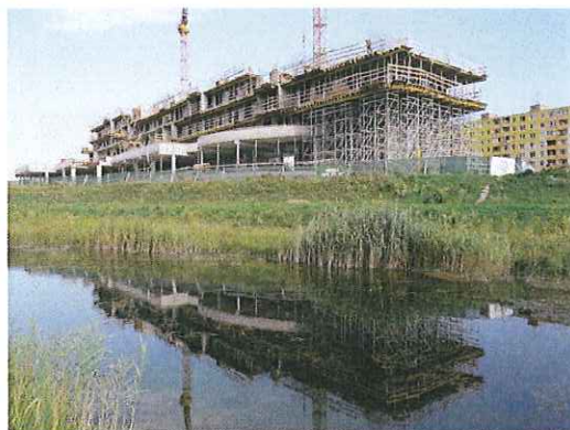
Petržalka city, Rusovská cesta/ Hálová ul., Bratislava SkyBau, s.r.o.
