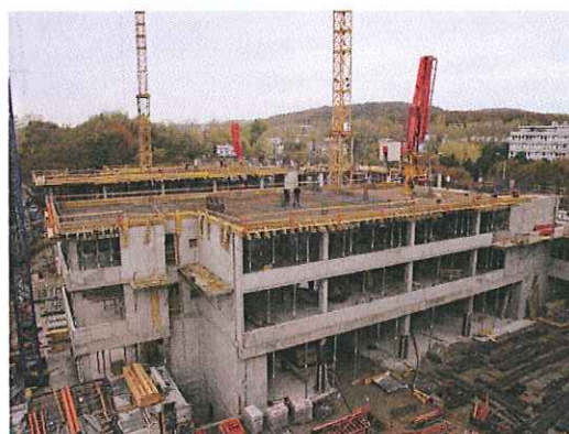
Administratívny komplex Westend Gate, Bratislava ZIPP BRATISLAVA spol. s r.o.
