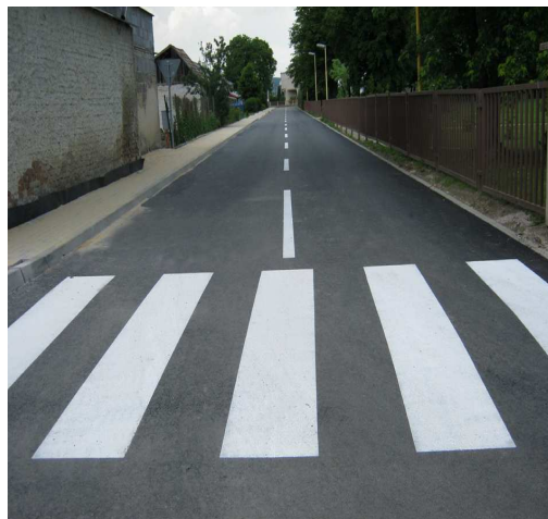
po rekonštrukcii – ulica pri kaštieli
