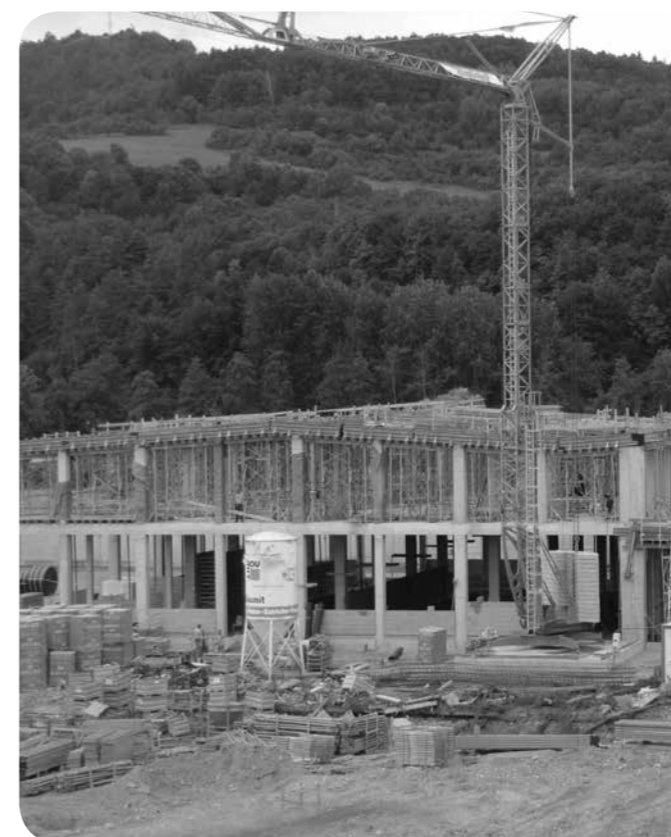
Foto: Výstavba centrálnej nabíjacej stanice, Continental Matador Rubber s.r.o., Púchov
