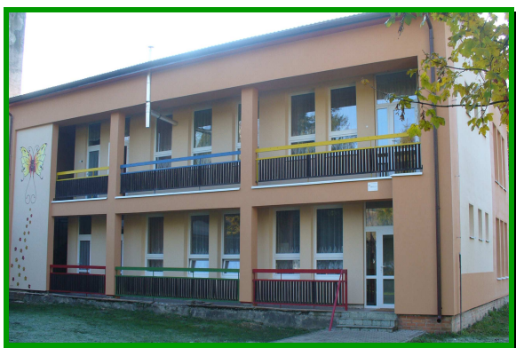
MŠ Stakčín po rekonstrukcii Stakčín, máj 2014
