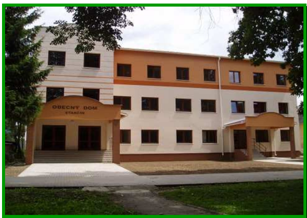
Budova Obecného domu po rekonstrukcii
