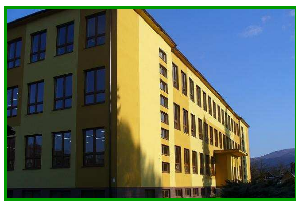
ZŠ Stakčín po rekonstrukcii
