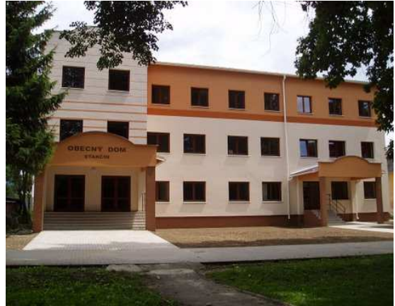
Budova Obecného domu (2007)
