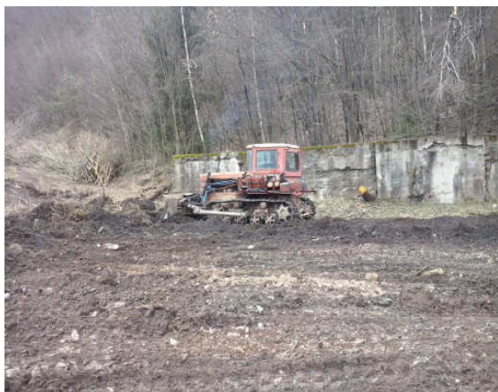
Zemné práce s DT -75 na ČOV
