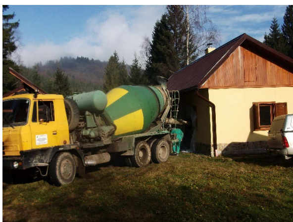
Rekonštrukcia chaty Rakovec
