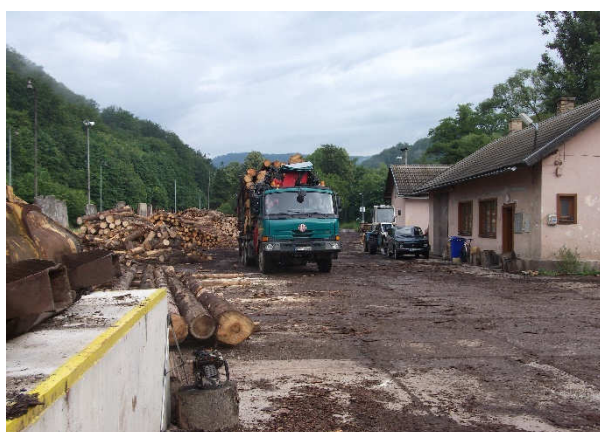
Budovy na ES pred opravou
