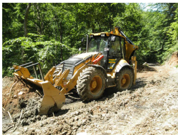
Oprava zväžnice v Šafárke vlastným prostriedkom – CAT
