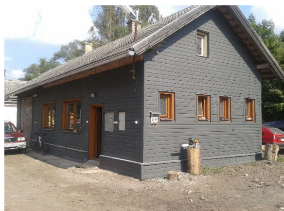
Budovy na ES po oprave
