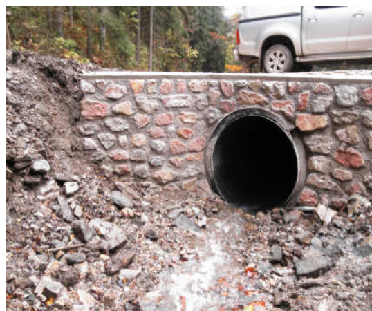
Stará Čuntavská cesta po oprave / Dodávateľ Lesostav Poprad/
