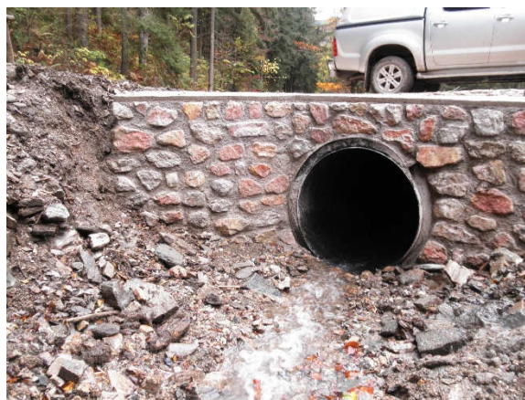
Rekonštrukcia Starej čuntavskej cesty
