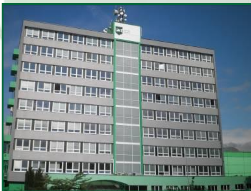
Obr. č. 1 / Pohľad na administratívnu budovu
