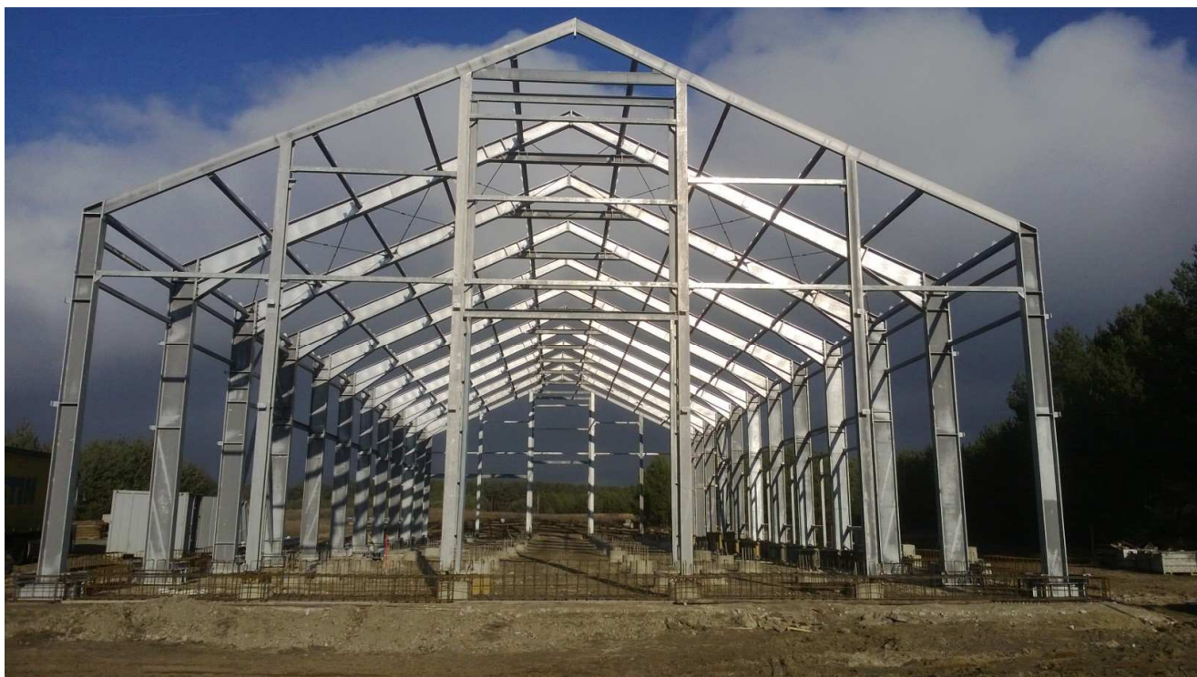
Hospodárska budova BIOFARMA TOMKY Dodávka a montáž ocelevej konštrukcie
