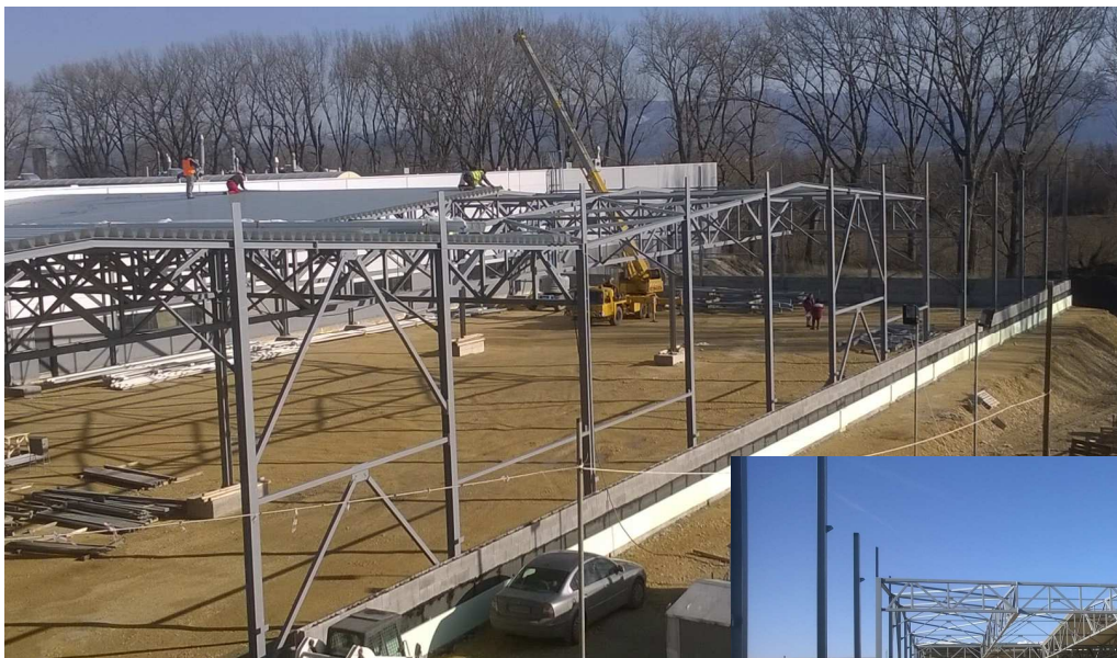
NISSENS Čachtice Prístavba haly – dodávka a montáž oceľovej konštrukcie
