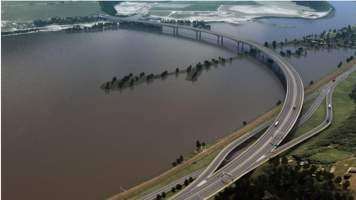
Obr. č. 3 Diaľnica D3 Žilina (Strážov) – Žilina (Brodno), Estakáda nad cestou I/11, železničnou traťou Bratislava – Žilina a Hričovskom nádržou
