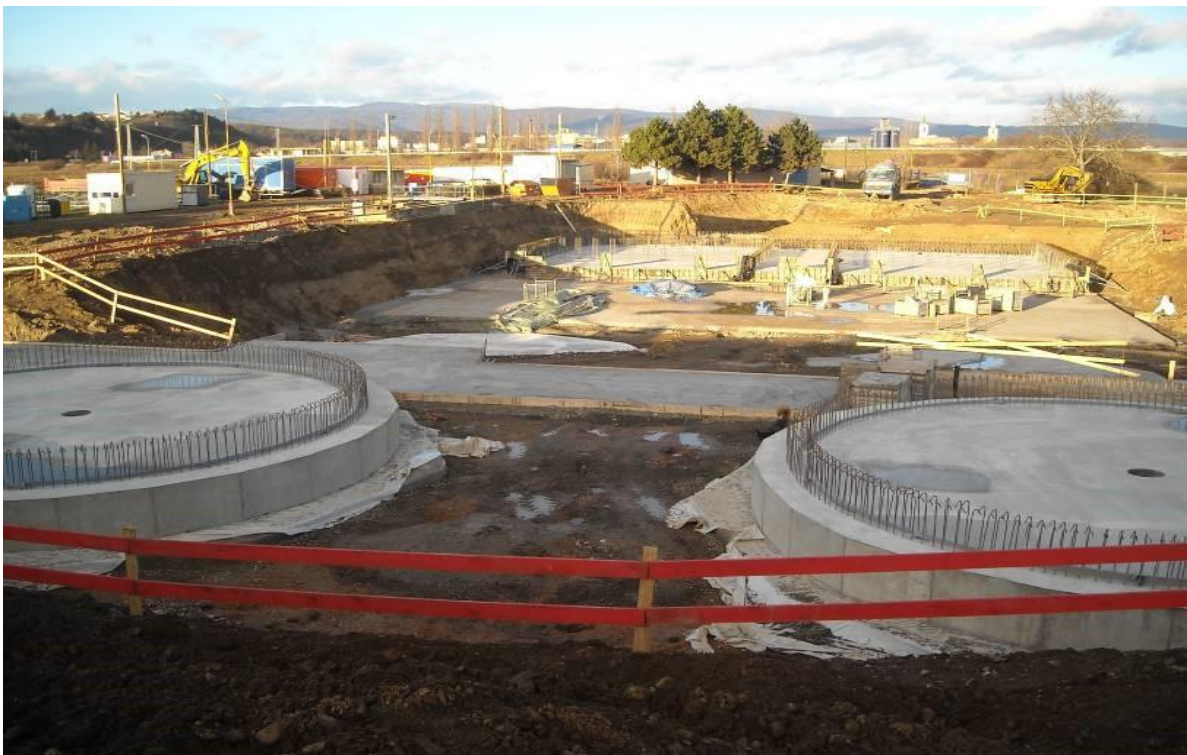
Obr. č. 16 ČOV Moldava nad Bodvou , pohľad na ČOV
