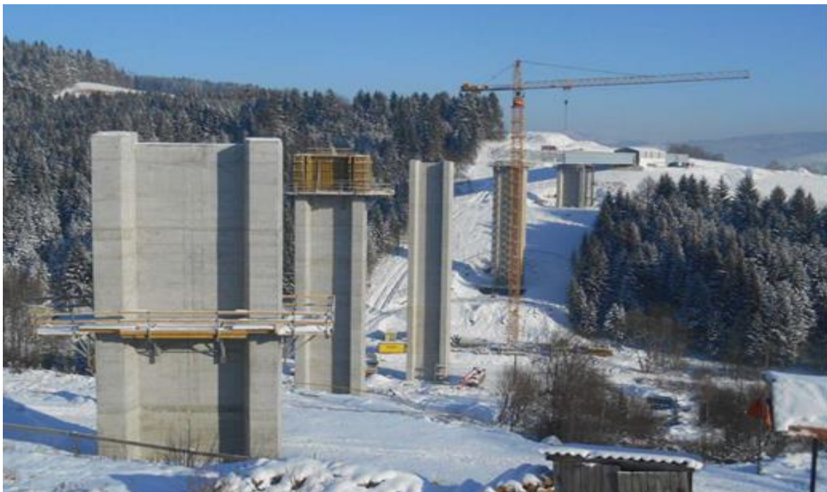
Obr. č. 10 Diaľnica D3 Svrčinovec – Skalité, most Vršok, spodná stavba
