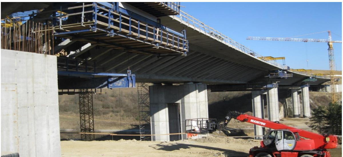
Obr. č.13. Diaľnica D1 Fričovce – Svinia
