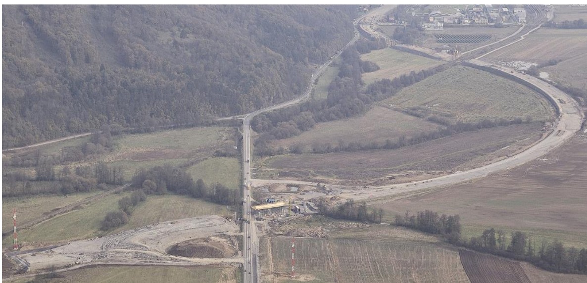
Obr. č. 11 Rýchlostná cesta R2 Pstruša – Kriváň, pohľad na začiatok úseku s križovatkou Pstruša
