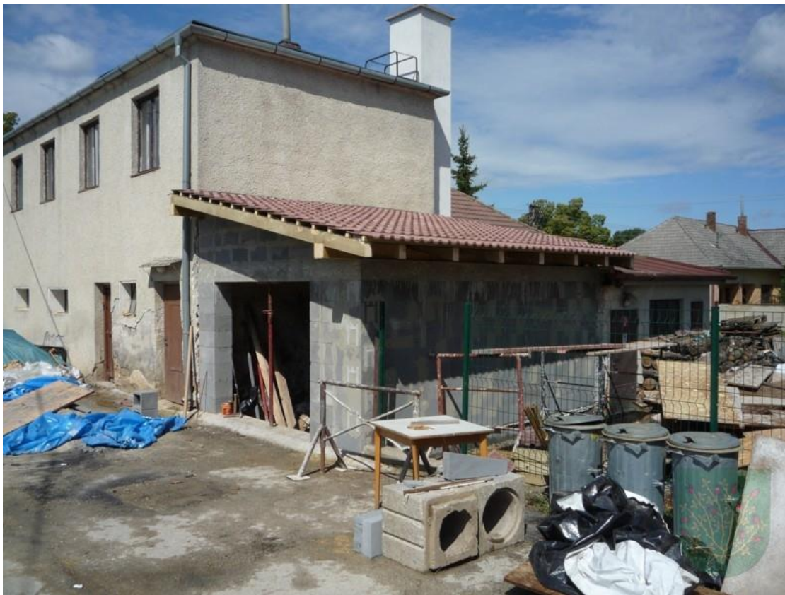
Oprava skladu paliva
