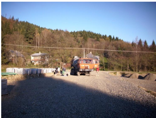
Stavenisko pri realizácii futbalového ihriska
