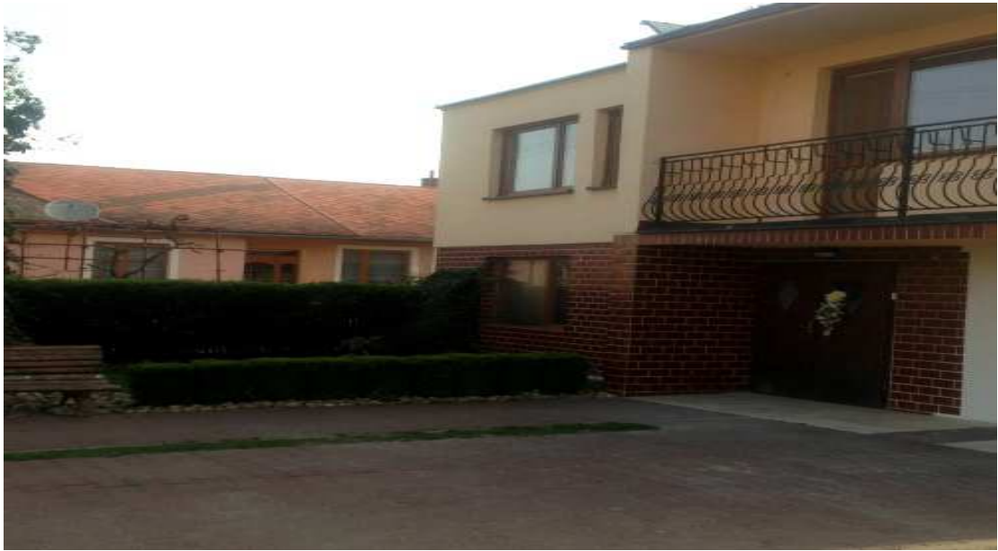
Domov sociálnych služieb FAMILIA,n.o. -exteriér
