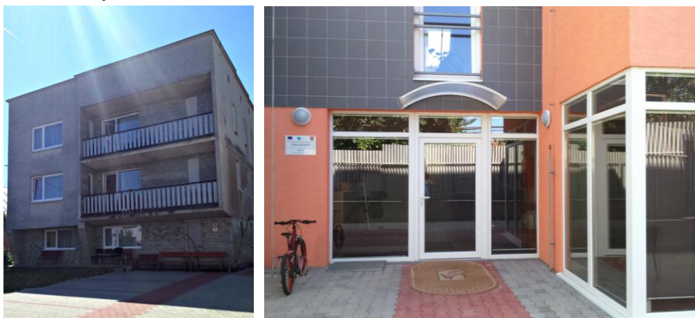
Obr. 1 Pôvodná budova a nová budova kolaudovaná v r. 2013
