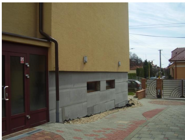
Vyhotovenie sokla na fasáde budovy – realizácia projektu
