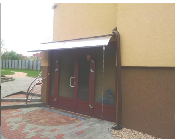
Prestrešenie preddveria chráni pred nepriazňou počasia a umožňuje bezpečný vstup do výtahu v prípade padania snehu a ľadových cencúľov
