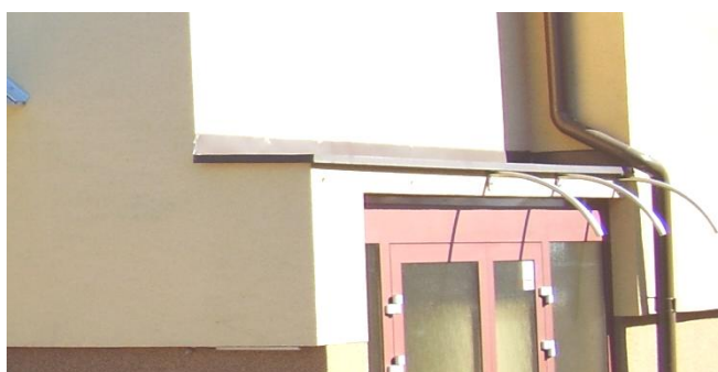
Prestrešenie preddveria chráni pred nepriazňou počasia a umožňuje bezpečný vstup do výtahu v prípade padania snehu a ľadových cencúľov
