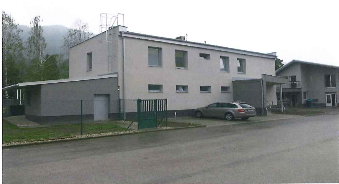
Administratívna budova spoločnosti
