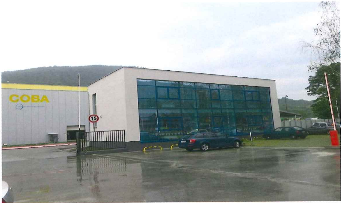
Administratívna budova spoločnosti
