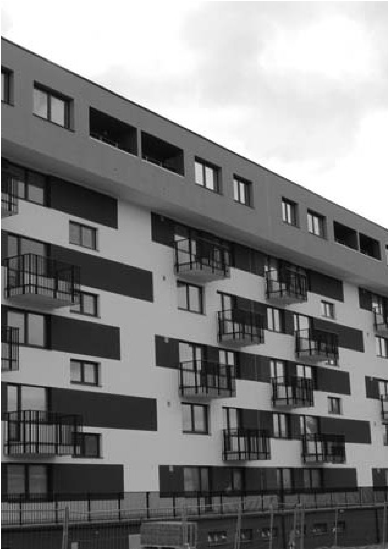
Bytový dom Jesenský vršok, Banská Bystrica
