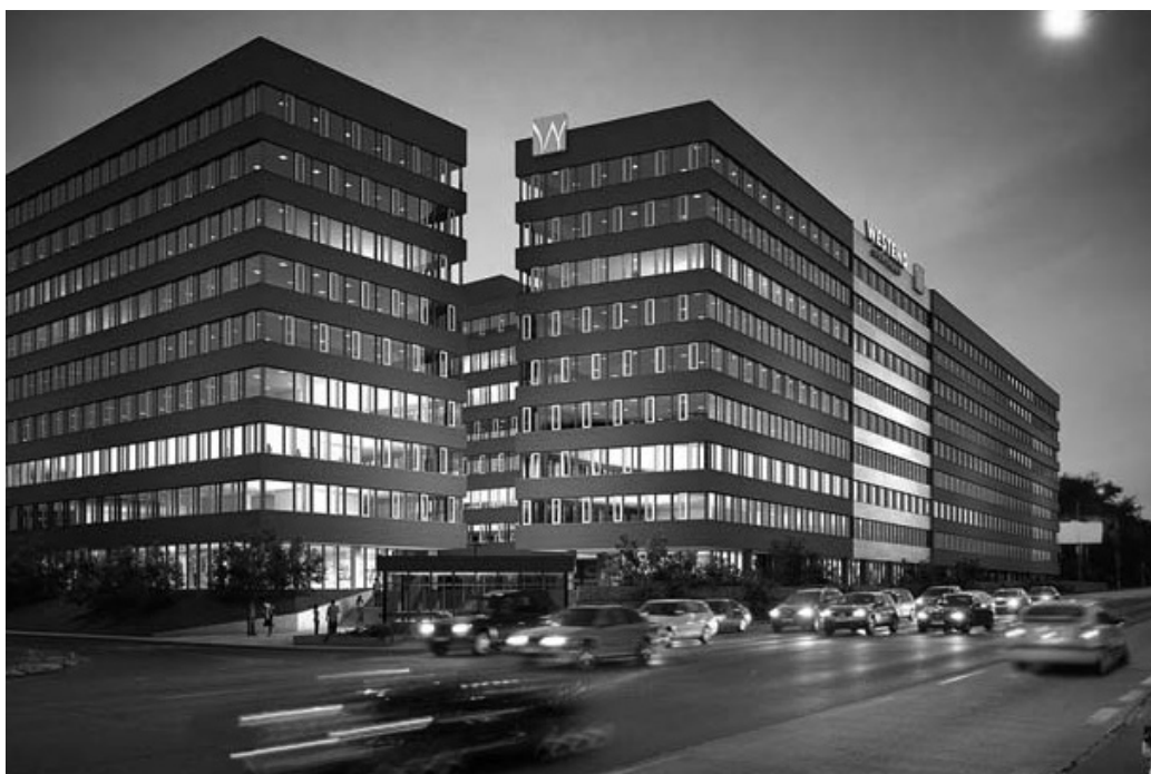
Polyfunkčný objekt WESTEND QUADRANT, Bratislava
