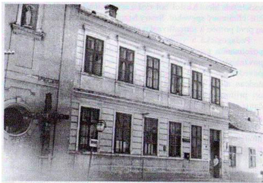
Budova kláštora sestier svätého Kríža v Pečeňadoch
