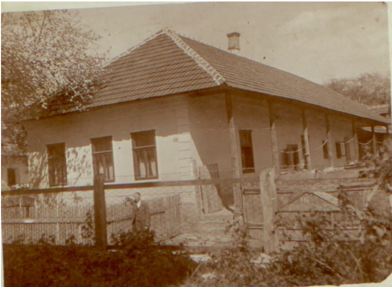
Stará fara Kocelovce, vpredu br. Farár Pošta
