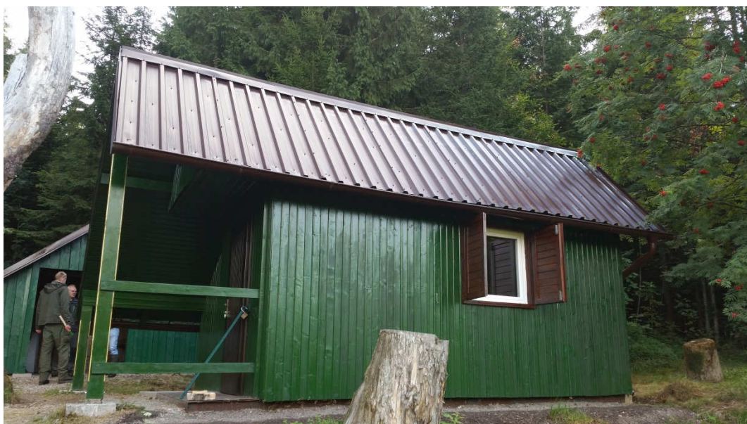
Zrekonštruovaná chata Mláky
