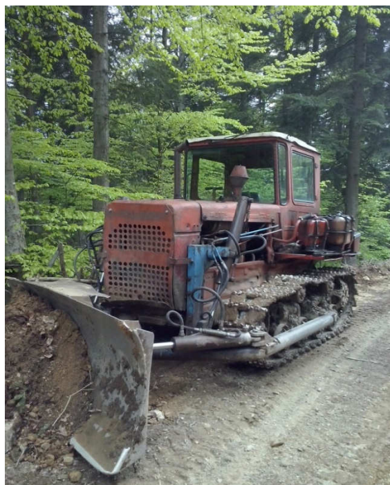
Opravy lesných ciest – dozér DT 75
