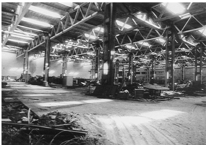
Výrobná hala pred rekonštrukciou zachytená objektívom nemeckých manažérov. Až na poškodený a nepoužiteľný stavebný materiál zívava prázdnotou.
