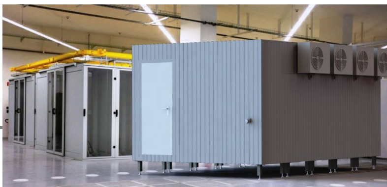
Obr. č. 11 / Modulárny kontajner IT LONG 5-3 (schéma)
