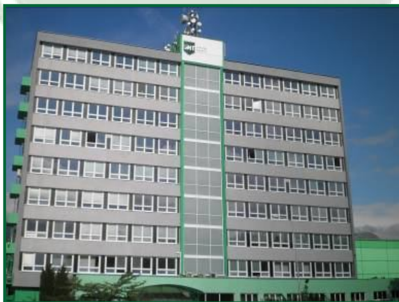
Obr. č. 1 / Pohľad na administratívnu budovu
