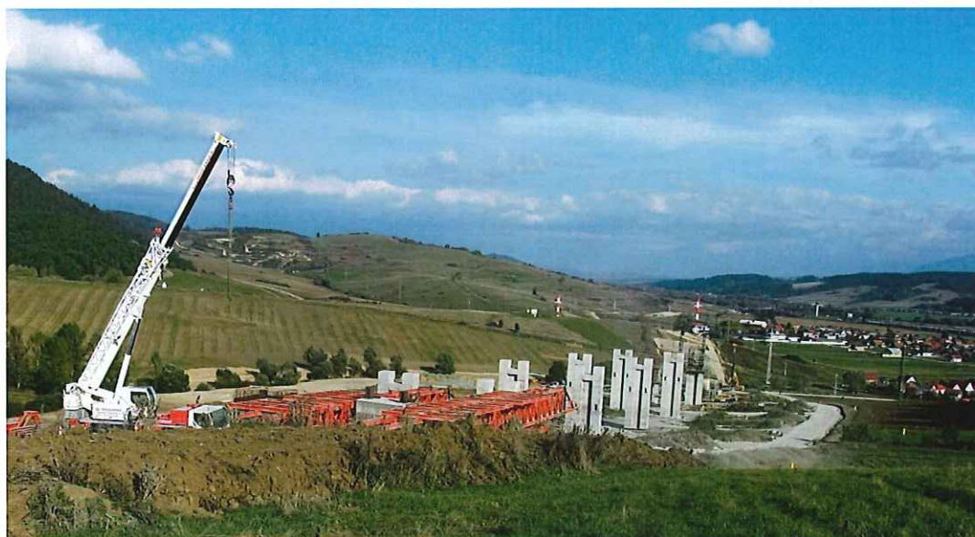
Obr. č. 9 Výstavba druhého najdlhšieho mostu úseku diaľnice D1 Hubová – Ivachnová, most SO 214. Dĺžka mostu – 694 metrov
