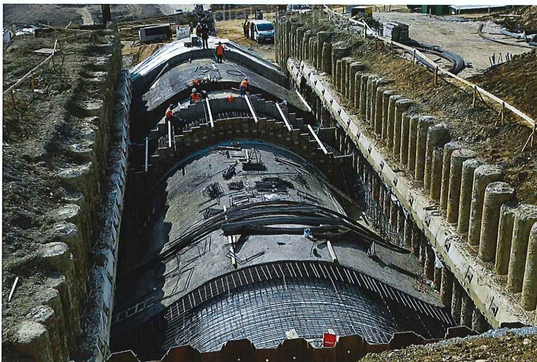
Obr. č. 12 Stredná časť tunela Považský Chlmec
