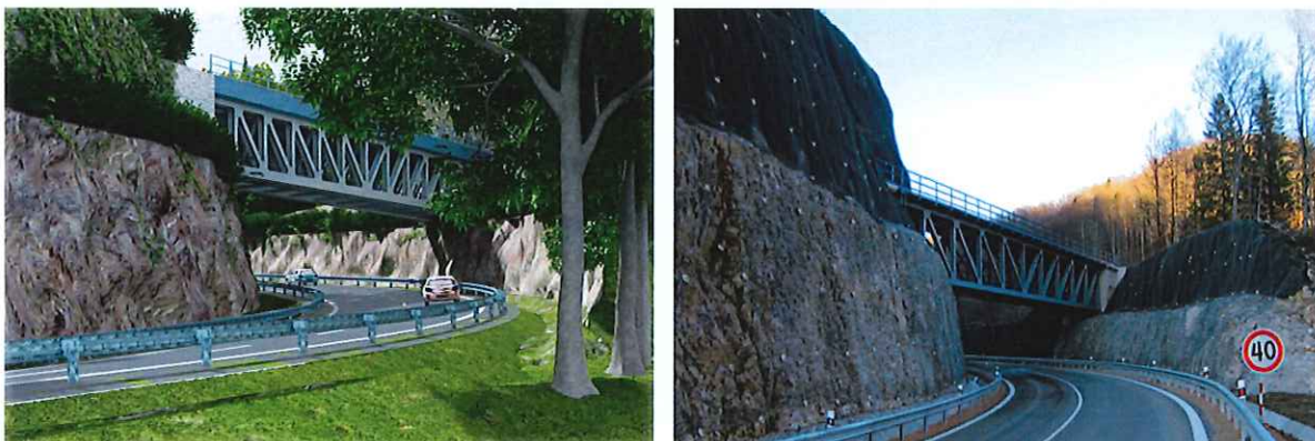
Obr. č. 29 a 30 Vizualizácia a reálny stav oceľového železničného mostu
