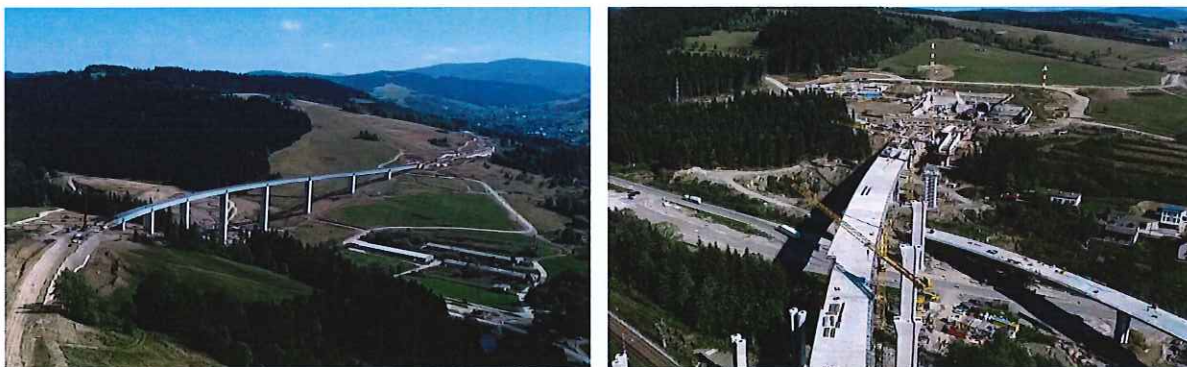
Obr. č. 13 a 14 Mostné objekty na diaľnici D3 Svrčinovec - Skalité
