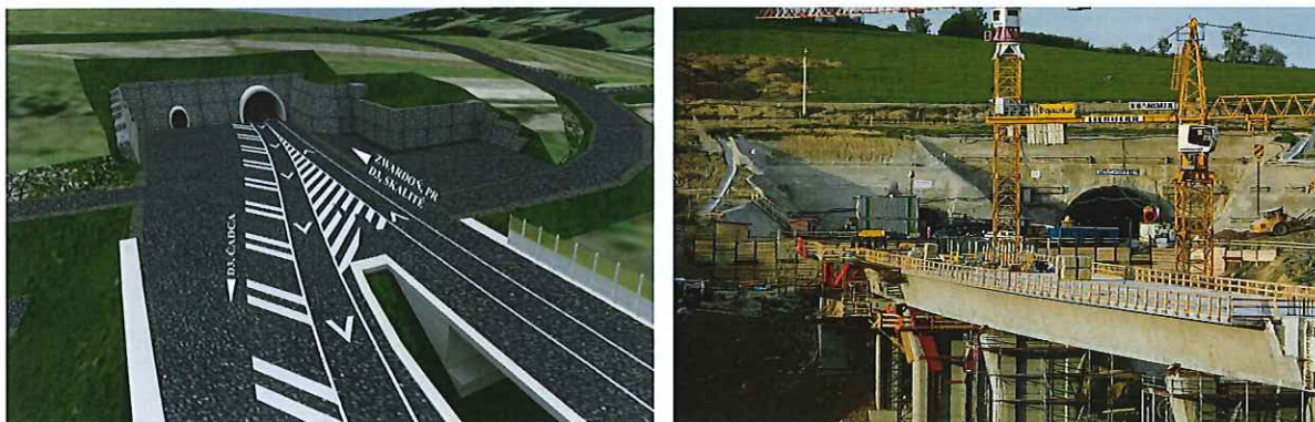
Obr. č. 15 a 16 Vizualizácia a výstavba západného portálu tunela Svrčinovec
