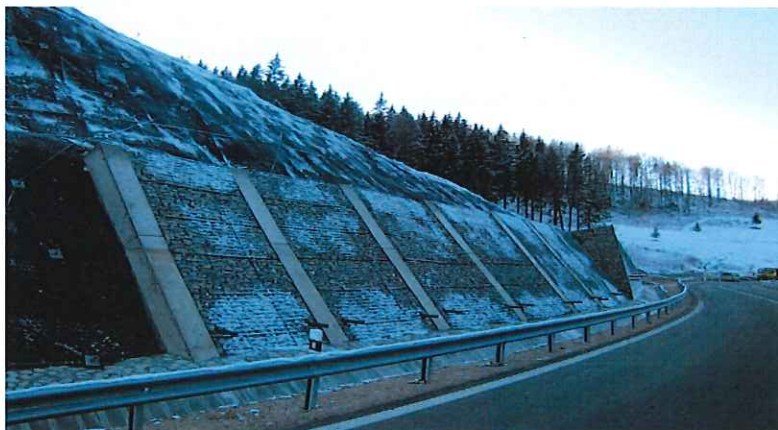
Obr. č. 31 Úprava skalného zárezu na ceste I/72
