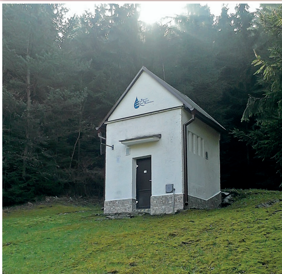
Vodárenský objekt Vodojem Valaská Dubová – zrekonštruovaný objekt
