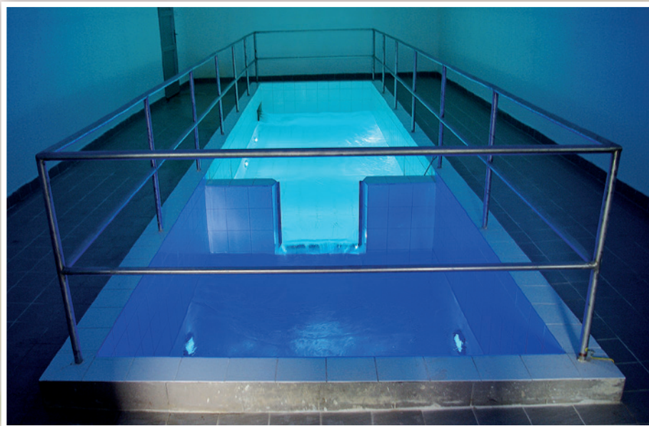
Vodárenský objekt – Vodný zdroj Jazierce
