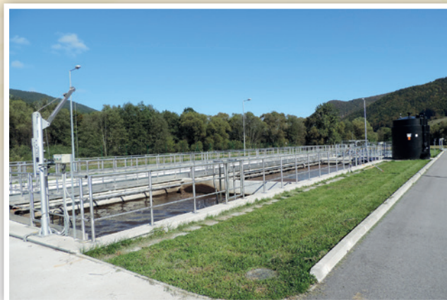
ČOV Liptovská Osada
