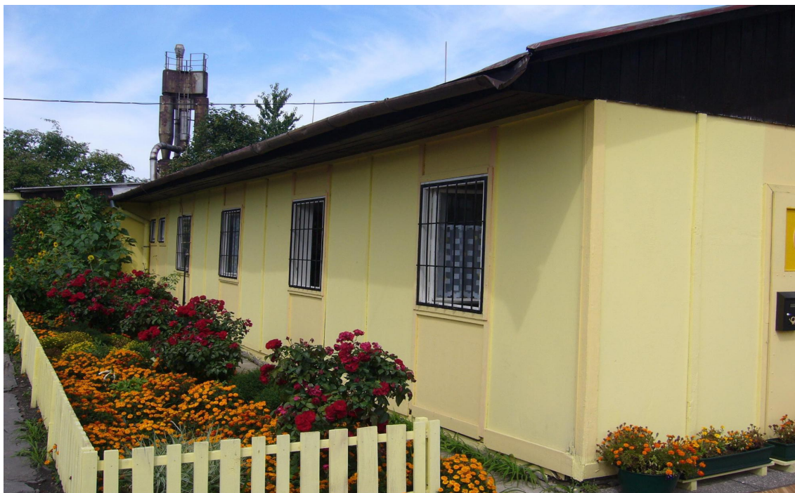
Prevádzková budova KRUH, n. o.
