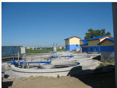
ČOV Leopoldov je mechanicko-biologická ČOV s odstraňovaním nutričov a s aeróbnou stabilizáciou kalu. Pôvodná ČOV Leopoldov bola v roku 2004 odstavená ako nefunkčná a odpadové vody z mesta Leopoldov a z obce Červeník boli čistené na ČOV NVÚ a ÚVV Leopoldov. V rokoch 2011 – 2012 začali na pôvodnej ČOV rekonštrukčné práce a na začiatku roka 2015 bola spustená do skúšobnej prevádzky. Na ČOV Leopoldov sa v priebehu roka 2015 vyčistilo 161 082 m<sup>3</sup> odpadovej vody.
