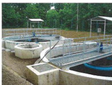
Na ČOV Dechtice bola v septembri 2014 ukončená skúšobná prevádzka. Počas tejto doby sa na ČOV nevyskytli výrazné problémy, ktoré by zásadným spôsobom ovplyvnili chod čistiarne. V priebehu sledovaného obdobia sa na ČOV Dechtice vyčistilo  $352\ 419\ m^3$  odpadovej vody a  $10\ m^3$  žumpových vód.
