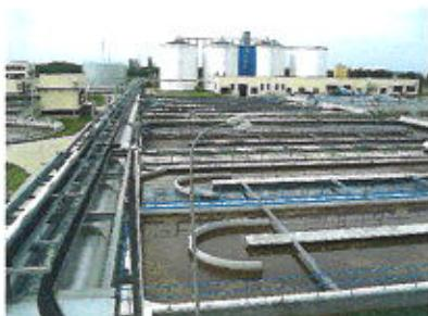
ČOV Zeleneč bola v priebehu roka 2014 prevádzkovaná v súlade s platným rozhodnutím na užívanie stavby a schváleným prevádzkovým poriadkom. V prevádzke boli obe linky. Čistiareň počas uvedeného obdobia mala viacero problémov (s vyplavovaním kalu do odtoku a tvorbou kalového koláča, látkové a hydraulické preťaženie dosadzovacích nádrží). Celkovo bolo na ČOV Zeleneč za rok 2014 vycistených 9 437 543 m<sup>3</sup> odpadovej vody a 3997,5 m<sup>3</sup> žumpových vôd.
