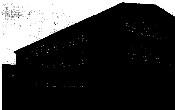
Základná škola pred stavebnými úpravami
