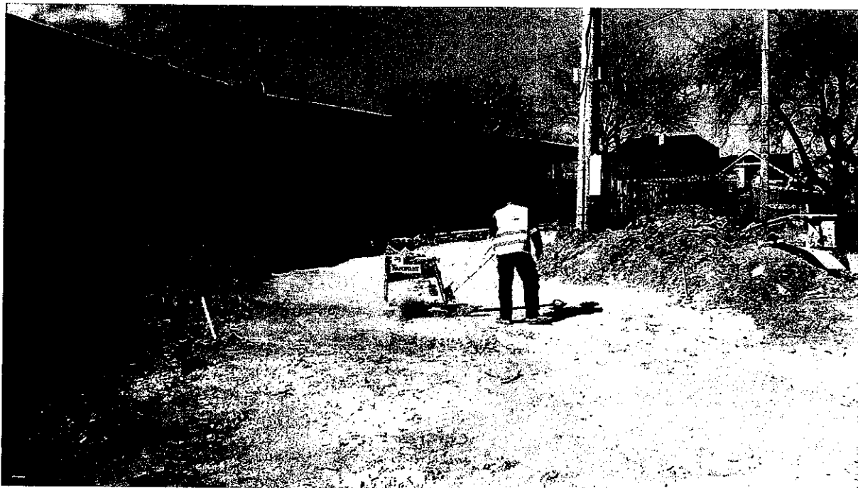
SO 32.38.06 STA Traťový úsek Trenčín - Trenčianska Teplá, komunikácia podchodu pre chodcov v nžkm 127,168, vrátane stien
