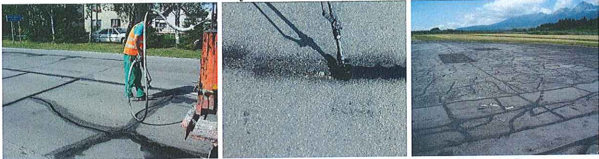
Zálievky dilatčných škár a trhlín v cemento-betónových krytoch
