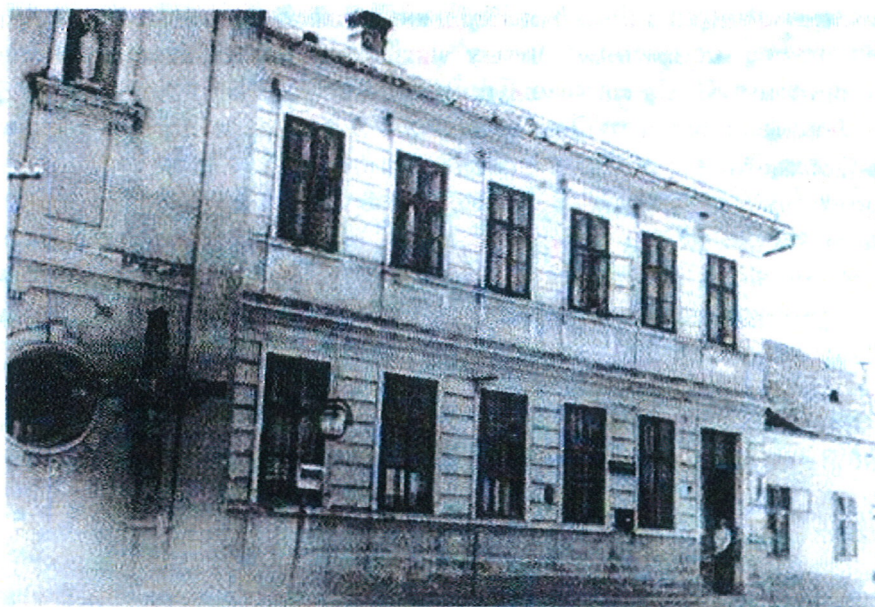
Budova kláštora sestier svätého Kríža v Pečeňadoch
