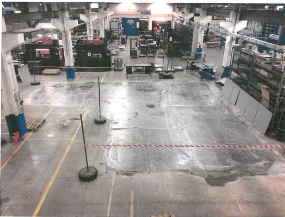
Obr.č.9 Nový základ pod laser
