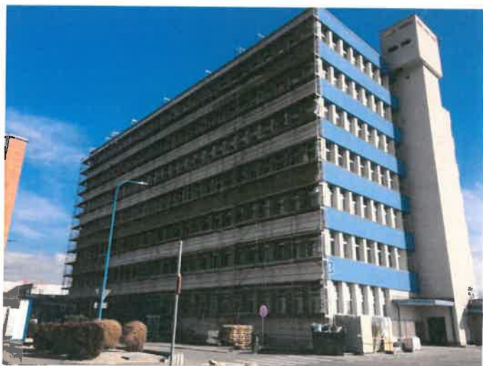
Obr.č.2 Realizácia zateplenia ,západná stena
