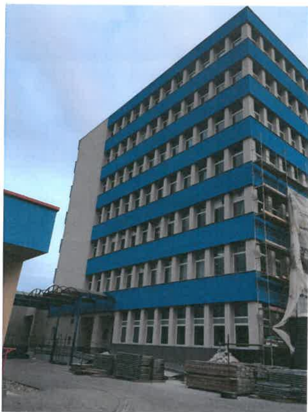
Obr.č.3 Nový stav fasády, severná stena
