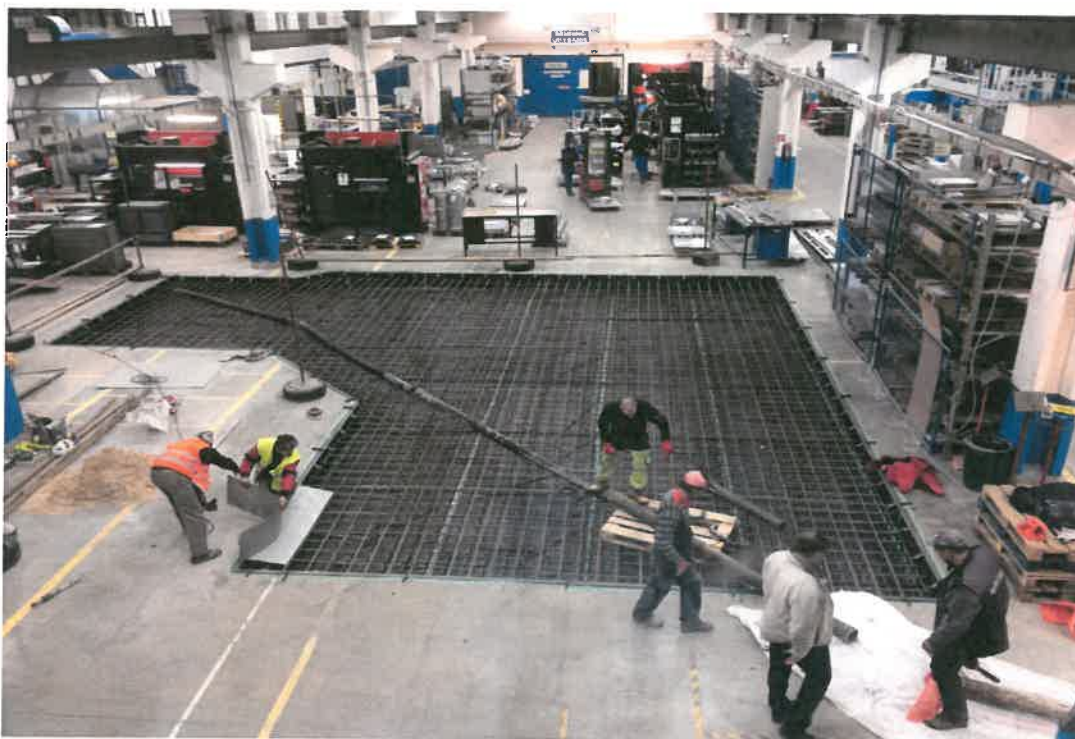
Obr.č. 8 Nový základ pod laser – výstuž
