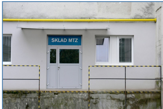
Fasáda pri sklade MTZ
