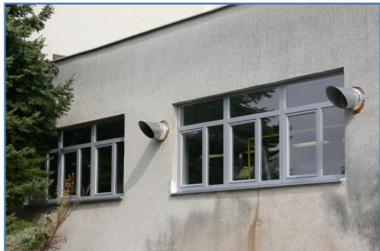
Okná na hospodárskom bloku
