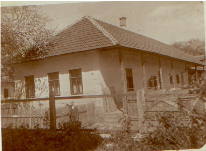
Stará fara Kocelovce, vpredu br. Farár Pošta
