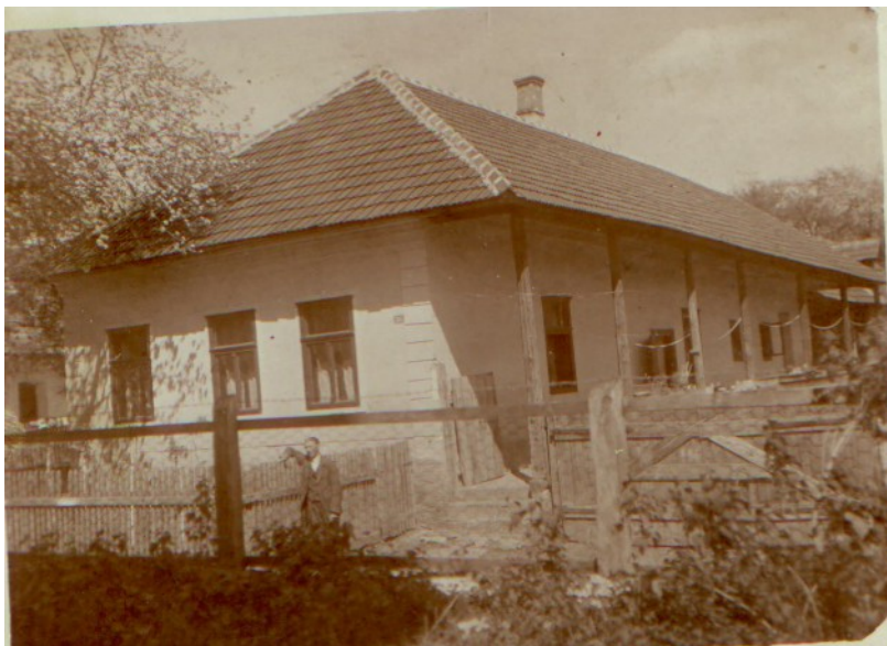
Stará fara Kocelovce, vpredu br. Farár Pošta
