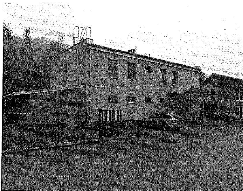
Administratívna budova spoločnosti
