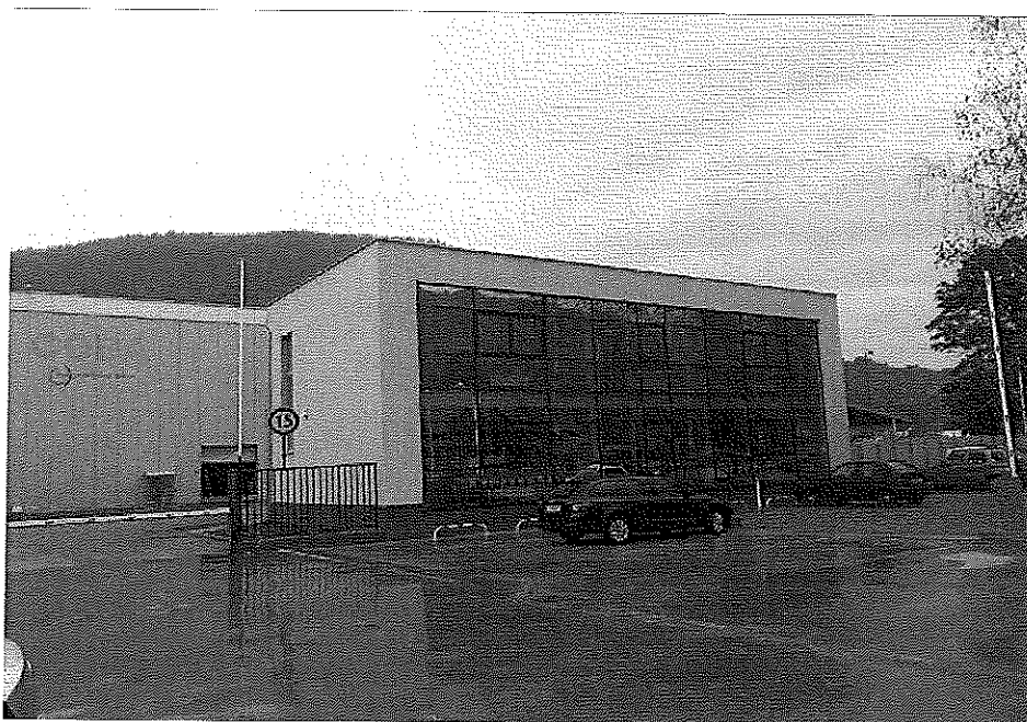
Administratívna budova spoločnosti
