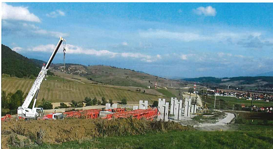
Obr. č. 10 Výstavba druhého najdlhšieho mosta úseku diaľnice D1 Hubová – Ivachnová, most SO 214. Dĺžka mosta – 694 metrov
