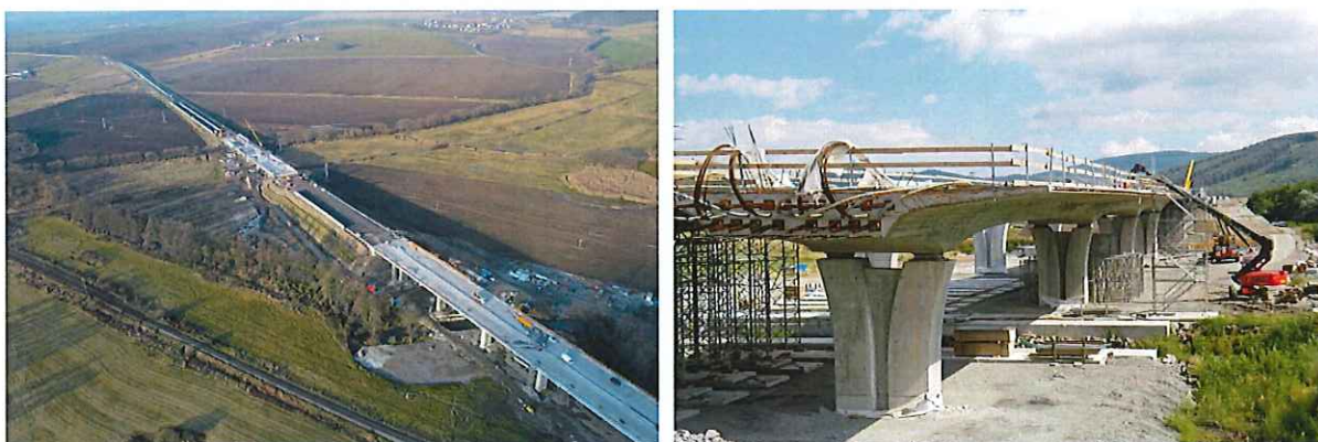
Obr. č. 36, 37 Pohľad na rozostavanú rýchlostnú cestu a most
