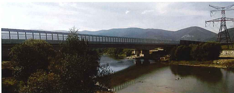
Obr. č.4 Mostný objekt 225 nad elektrifikovanou železničnou traťou a Krpelianskym kanálom v km 15,004 D1
