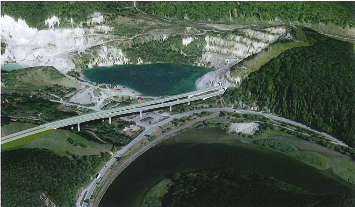
Obr. č. 7 Most nad osadou Rieka s tunelovými portálmi tunela Malá Fatra.
