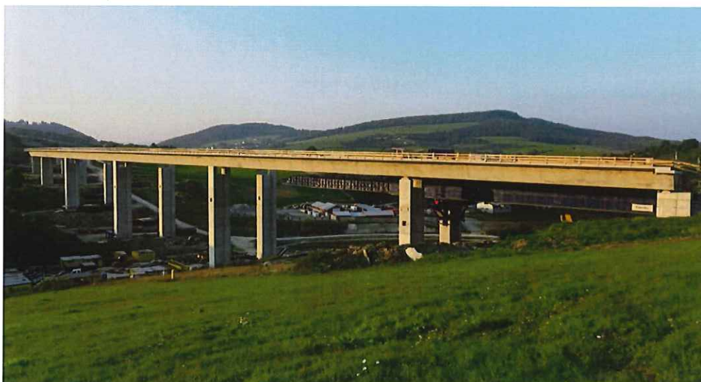
Obr. č. 2 Mostný objekt 204-00
