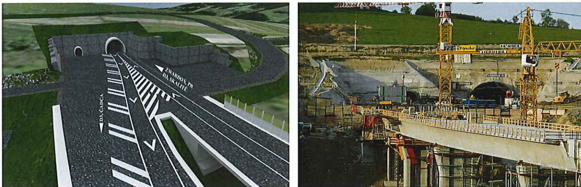
Obr. č. 19 a 20 Vizualizácia a výstavba západného portálu tunela Svrčinovec
