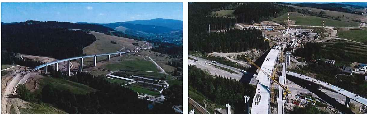
Obr. č. 17 a 18 Mostné objekty na diaľnici D3 Svrčinovec - Skalité
