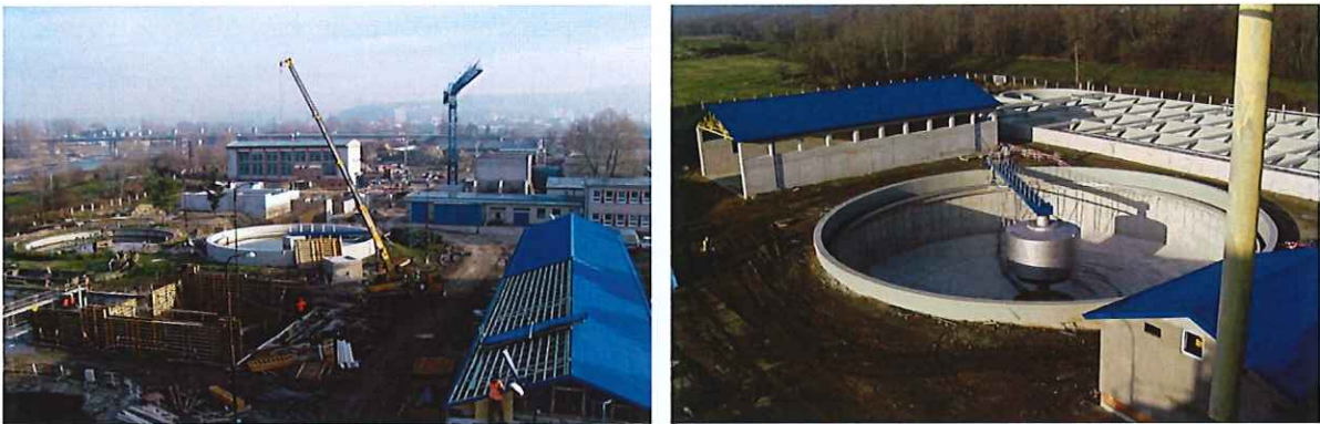
Obr. č. 50 a 51 Výstavba čističky odpadových vôd
