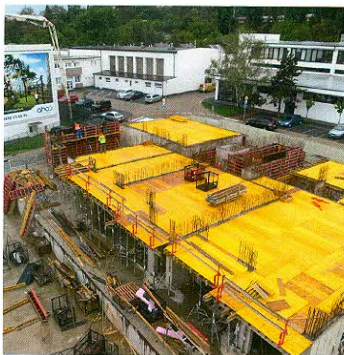
Výstavba bytového súboru AHOJ - Bratislava
