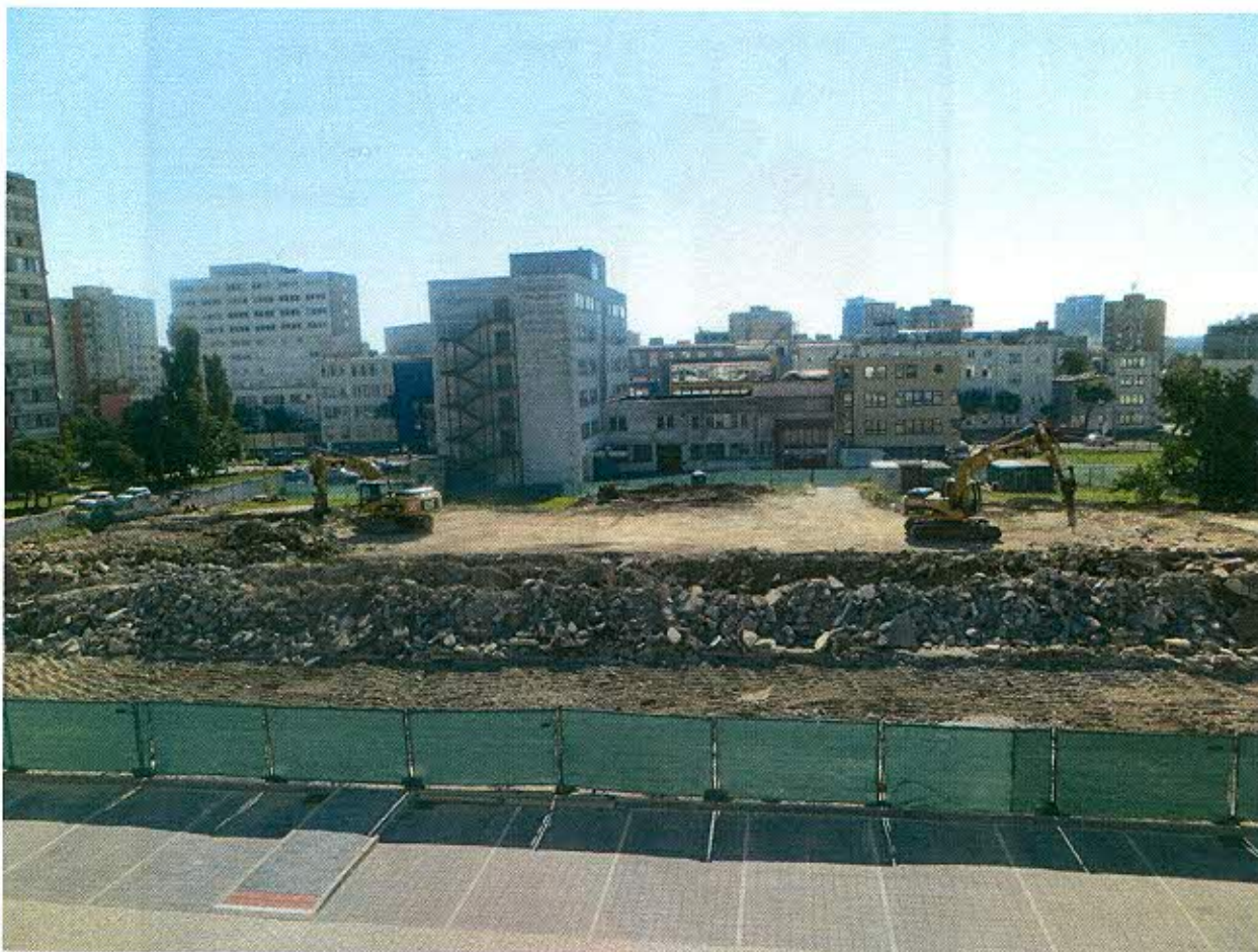
Výstavba bytového súboru AHOJ - Bratislava
