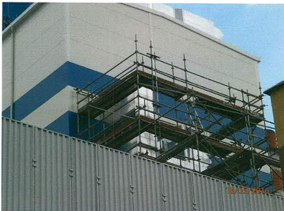
Rekonštrukcia PPC Energy
