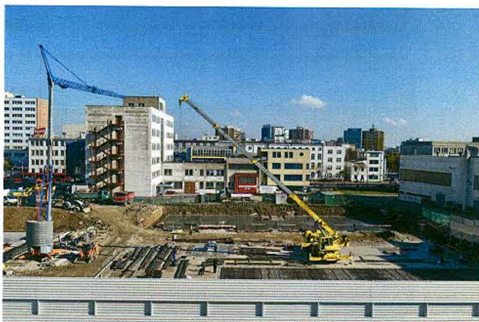
Výstavba bytového súboru AHOJ - Bratislava
