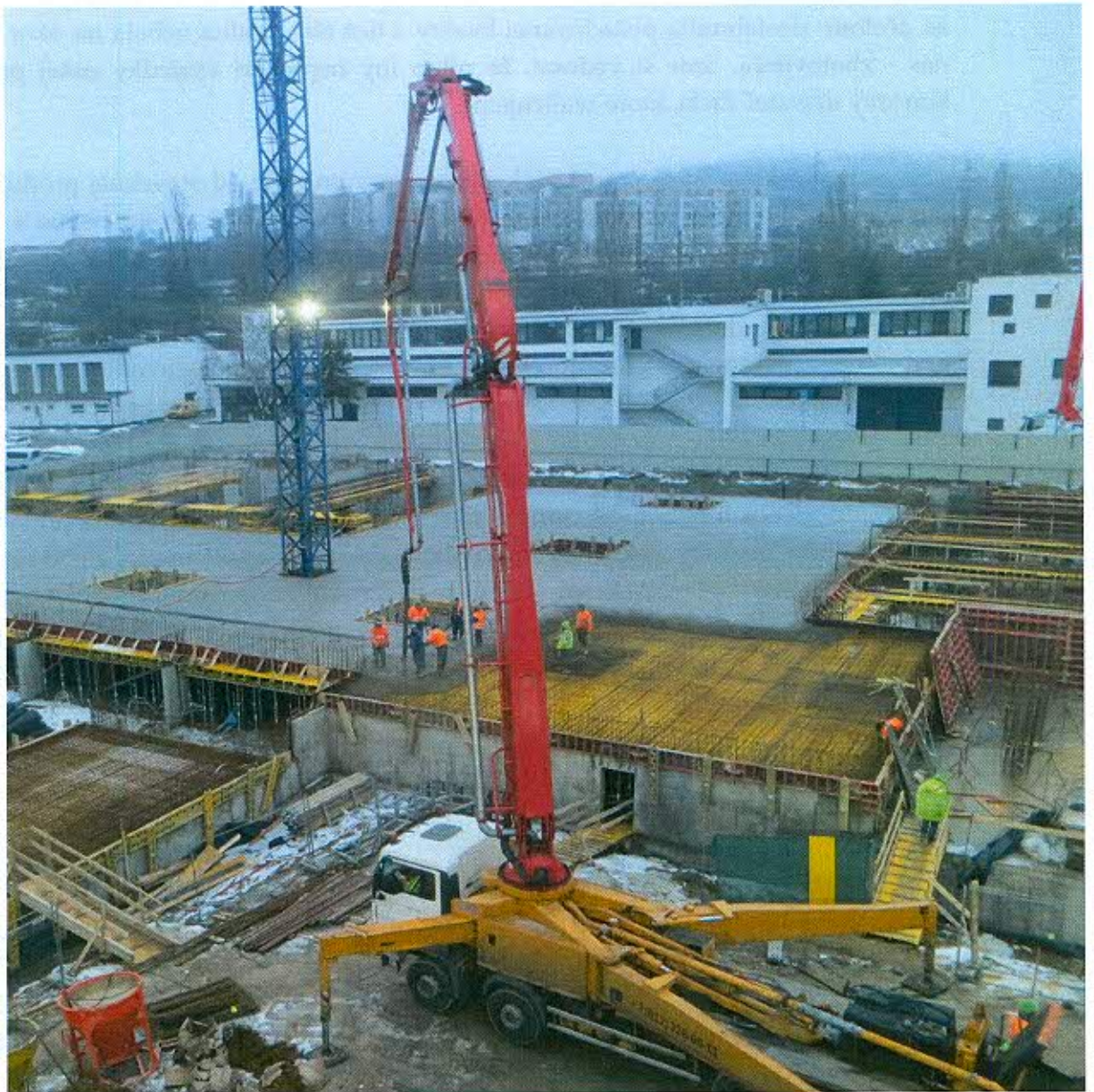
Výstavba bytového súboru AHOJ - Bratislava
