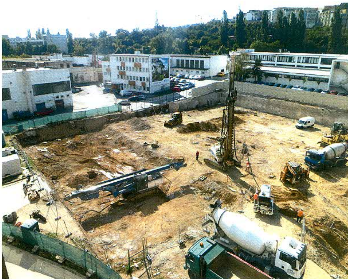
Výstavba bytového súboru AHOJ - Bratislava
