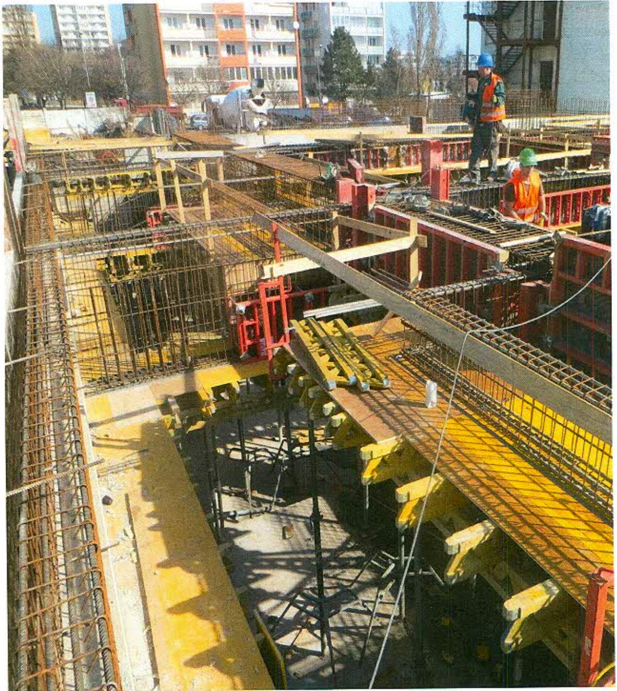
Výstavba bytového súboru AHOJ - PARK - Bratislava
