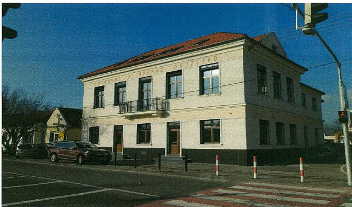
Administratívna budova v časti Bratislava Vajnory – po rekonštrukcii
