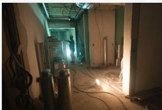
Priestory budúcej Dennej kliniky sa začali prestavovať a rekonštruovať na jeseň 2016.
