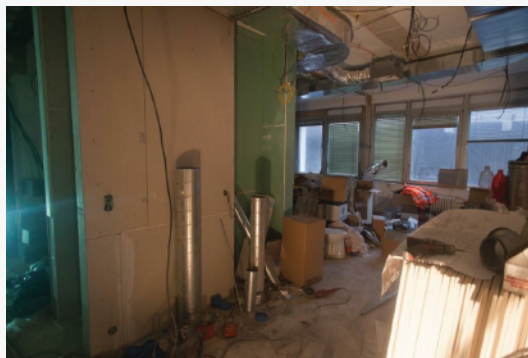
Priestory budúcej Dennej kliniky si vyžadovali kompletnú prestavbu vrátane zmien priečok, výmeny elektrických rozvodov, okien, novú vzduchotechniku a zdravotnícku a mnoho ďalších úprav.
