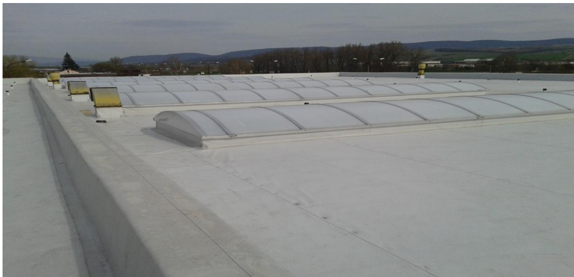
Strecha dielne v Rimavskej Sobote po oprave
