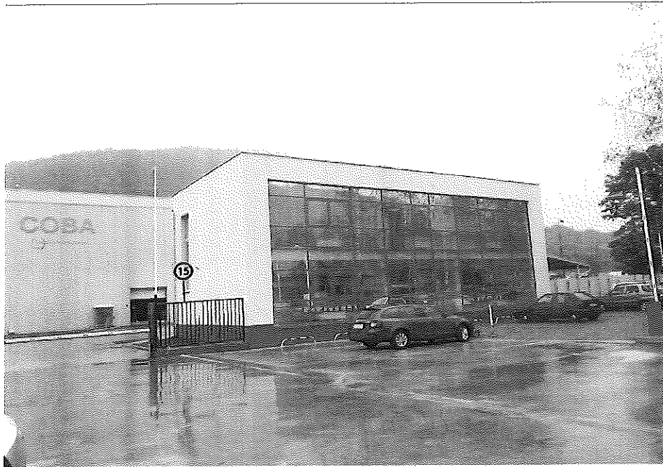
Administratívna budova spoločnosti
