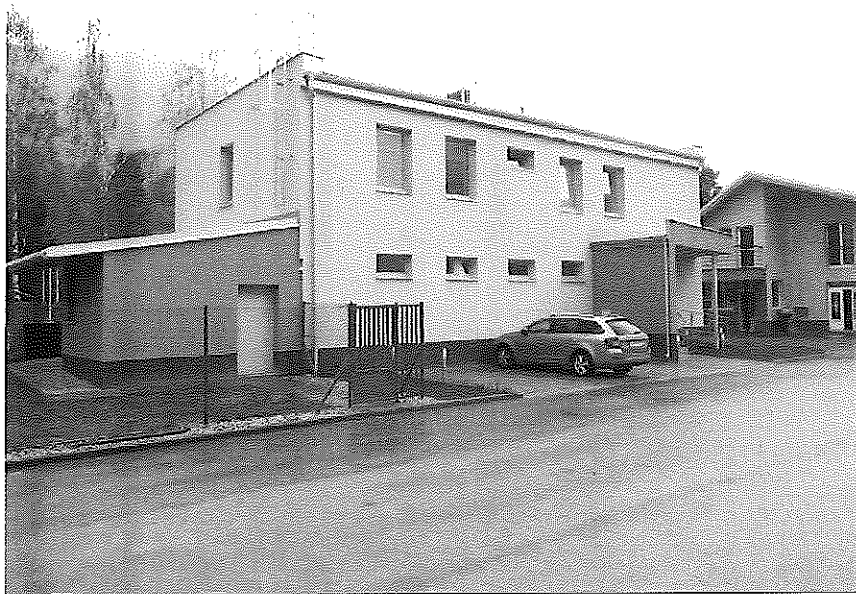
Administratívna budova spoločnosti
