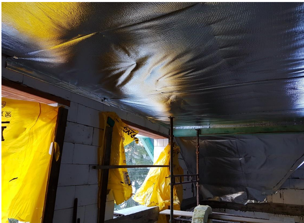
Vymurovanie nových štítov a zateplenie podkrovia
