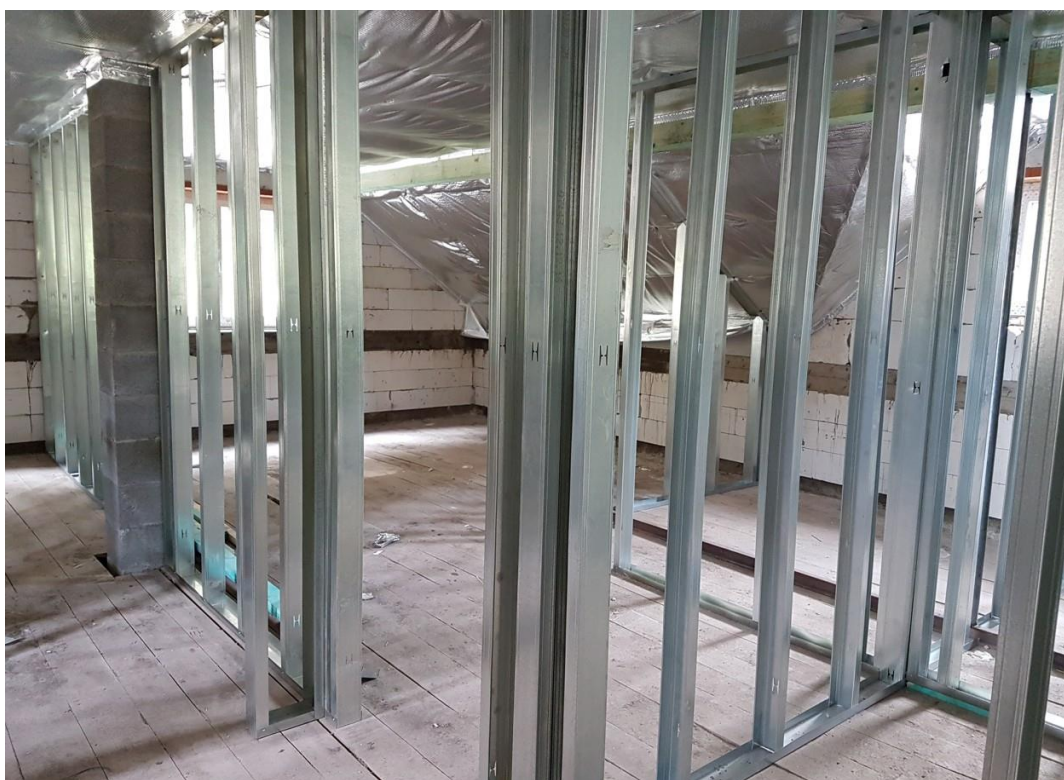
Príprava konštrukčných dielov pre zabezpečenie sadrokartónových priečok
