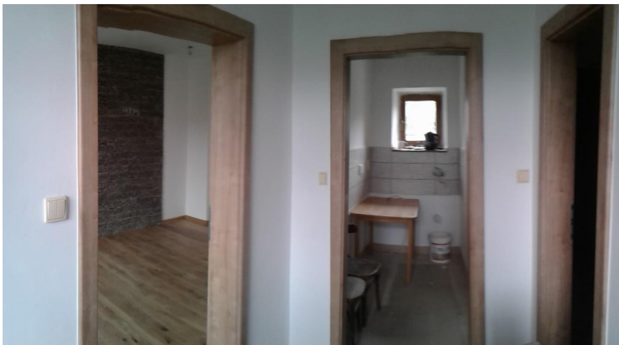
Oprava ubytovacieho zariadenia „Lesanka“, pred dokončením
