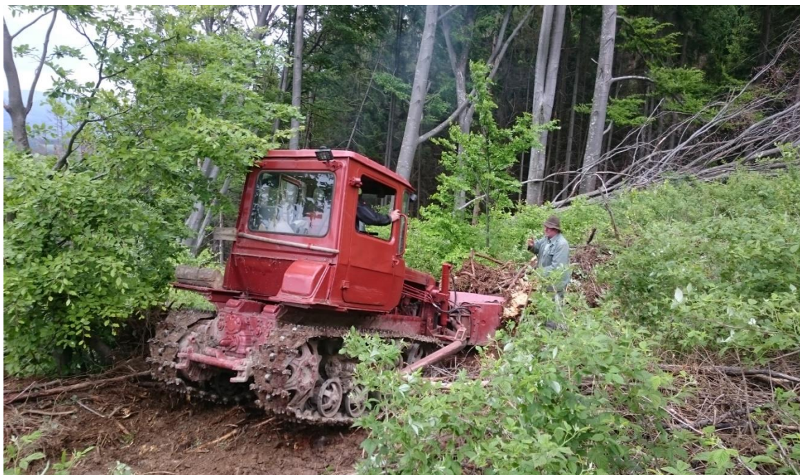
Výstavba novej približovacej linky dozerom DT 75
