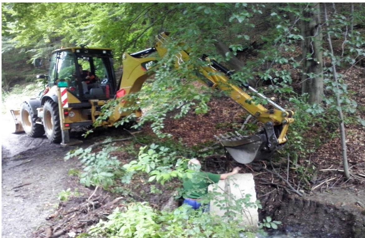
Oprava poškodeného priepustu - Za priehradou - LO 06 Čierna Hora
