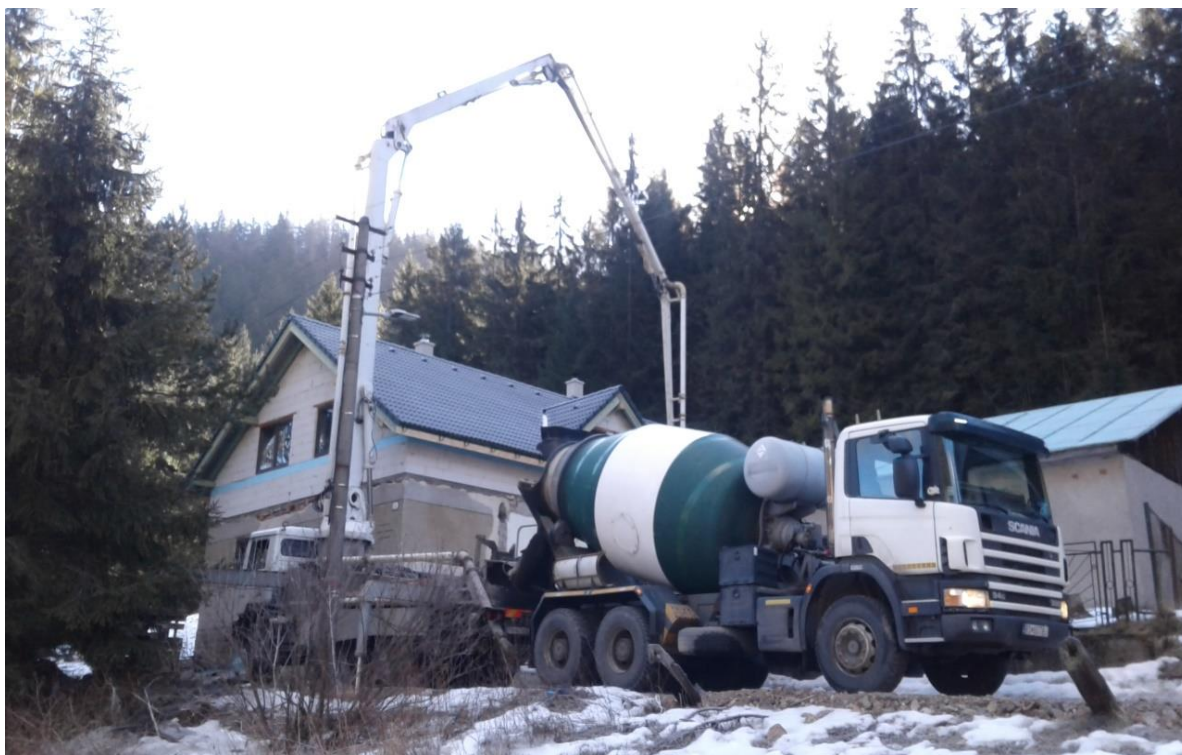
Betonáž podláh v objekte Ľadová
