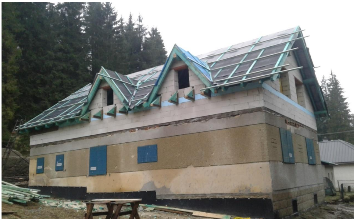
Oprava objektu v Dobšinskej Ľadovej Jaskyni - výmena starého krovu, podmurovanie venca a polozenie novej krytiny
