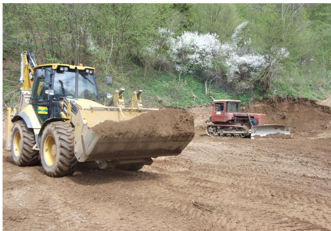
Caterpillar 343 F spolu s dozerom DT 75 pri terénnych úpravách
