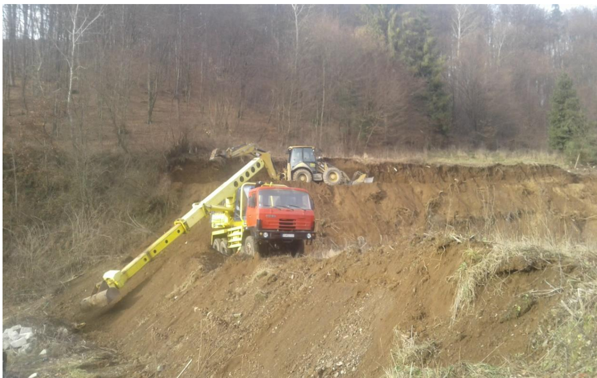
Zakúpená Tatra 815 UDS pri svahovacích prácach
