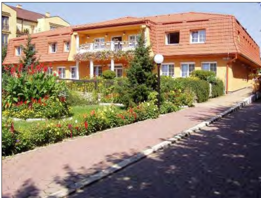
Obr. 26 Budova Spoločensko-relaxačného centra, Milosrdenstva 4
