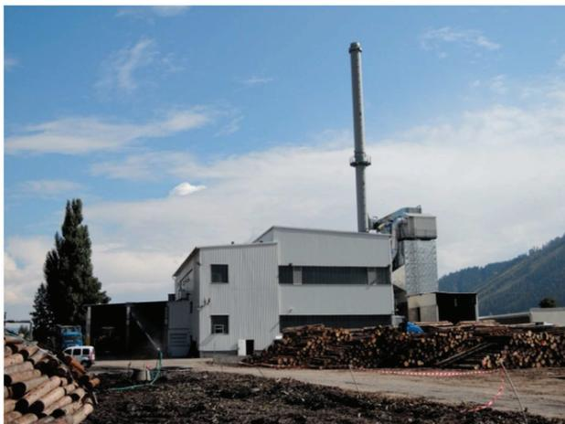
V tomto CO<sub>2</sub> neutrálnom procese výroby energií vzniká teplo a elektrická energia, ktoré sa významným podielom podieľajú na tržbách spoločnosti, ale predovšetkým sú využívané v ďalšom výrobnom procese. Vyrobené teplo sa primárne využíva pri sušení reziva do 10 % vlhkosti. Vyrobená elektrina tvorí až 90% celkovej spotreby elektriny výrobného závodu.
