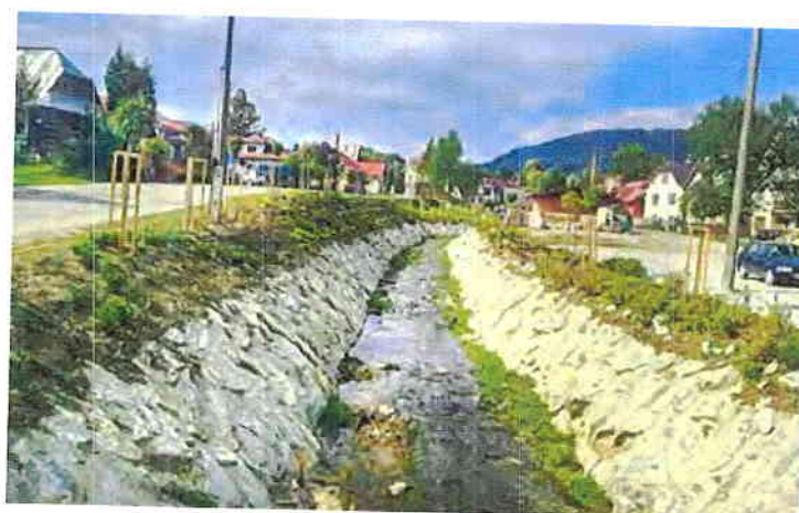
Stavba: "Ochrana pred povodňami"
