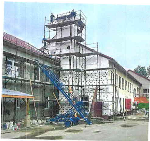
Rekonštrukcia budovy MŠ.
