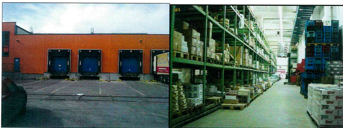
(prijem tovaru – sklad chladených a mrazených tovarov) (skladové priestory centrálného skladu)
