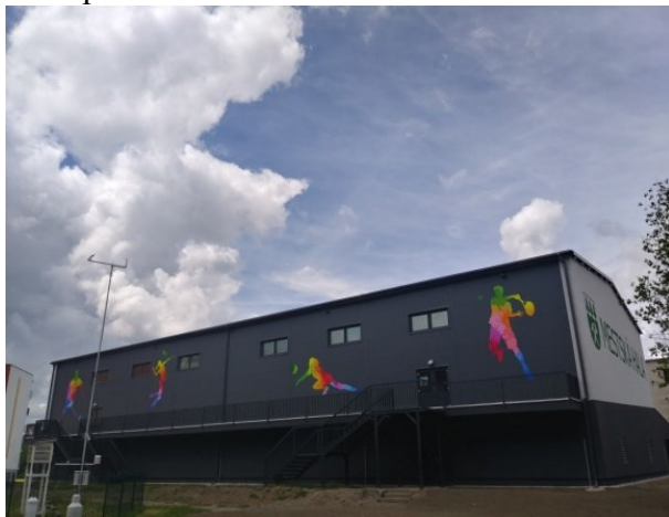
Stav po rekonštrukcii
