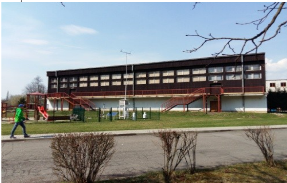
Stav pred rekonštrukciou
